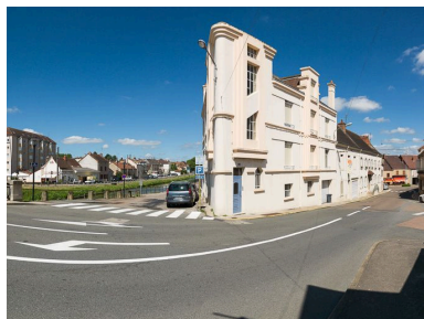
Vue de l'immeuble de style paquebot. Phot. Pierre-Marie Barbe-Richaud IVR26_20137100520NUC4AQ
