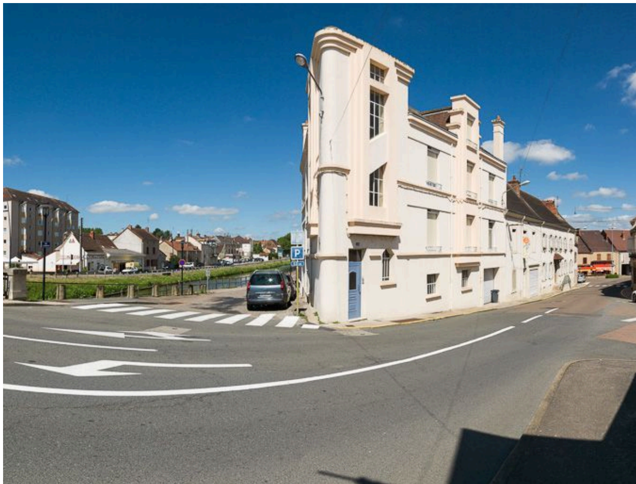
Vue de l'immeuble de style paquebot.
