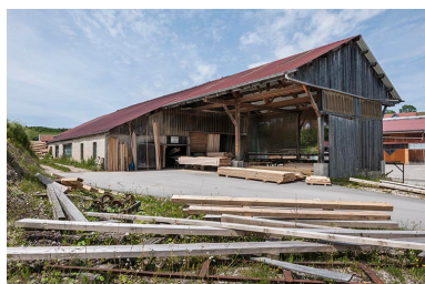
Atelier de fabrication. Phot. Jérôme Mongreville IVR43_20152501470NUC4A
