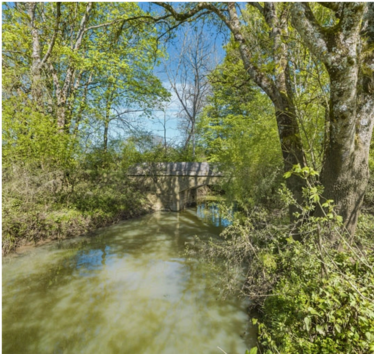
Vue d'ensemble du pont.
