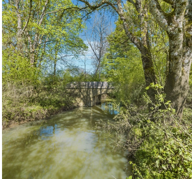
Vue d'ensemble du pont. Phot. Thierry Kuntz IVR26_20162100067NUC4A
