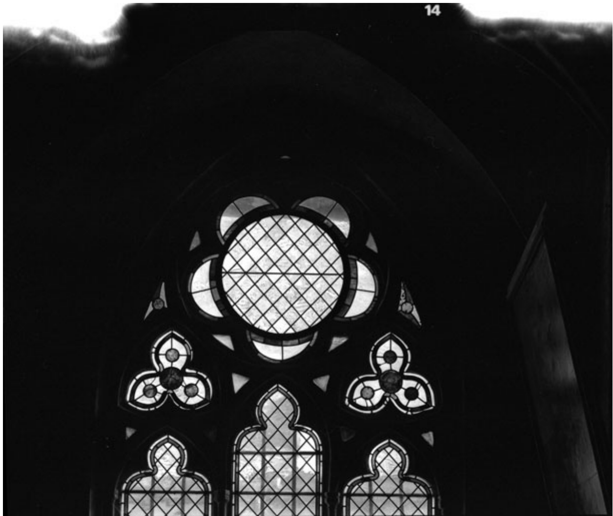
Partie supérieure de la baie.
