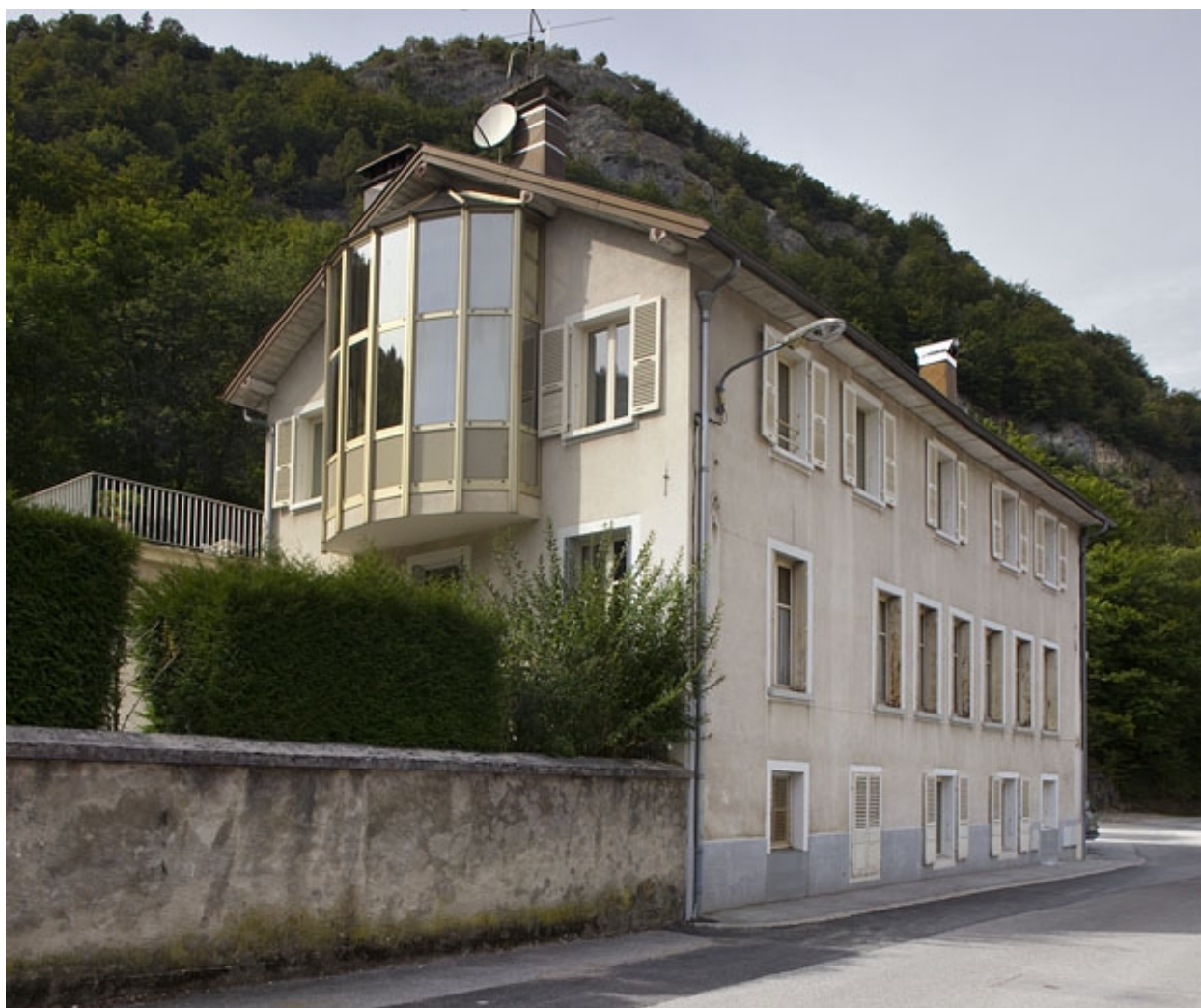
Elévation antérieure, de trois quarts gauche.
