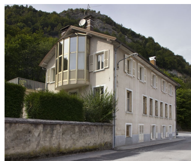
Elévation antérieure, de trois quarts gauche. Phot. Yves Sancey IVR43_20103900514NUC2A
