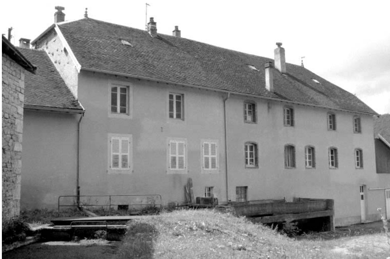
Façade postérieure du premier atelier de fabrication.
