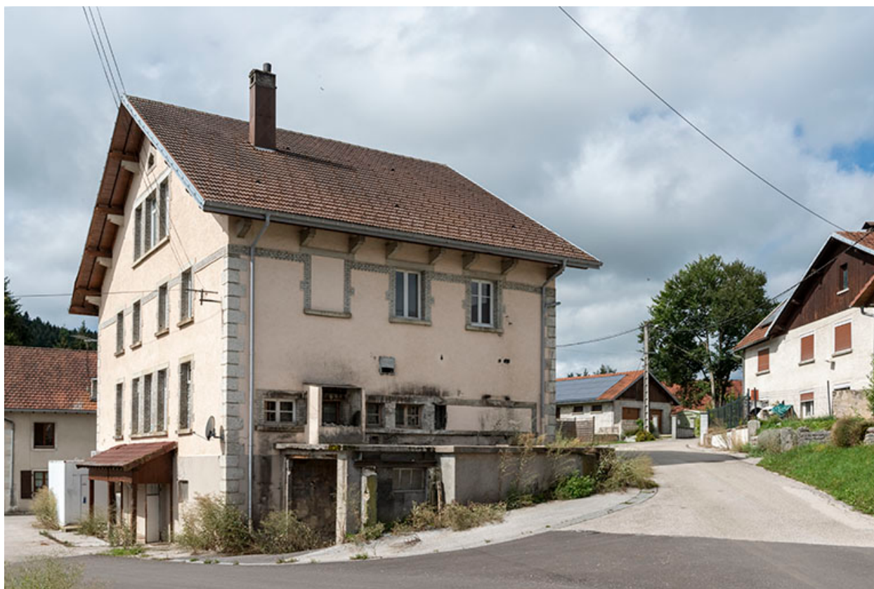
Façades postérieure et latérale gauche.
