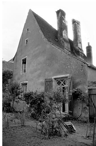
Façade postérieure. Phot. Bernard Lardière IVR43_19817000826Z
