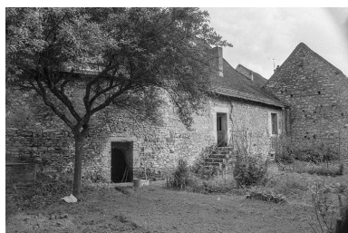
Dépendance au fond du jardin. Phot. Bernard Lardière IVR43_19817000827Z
