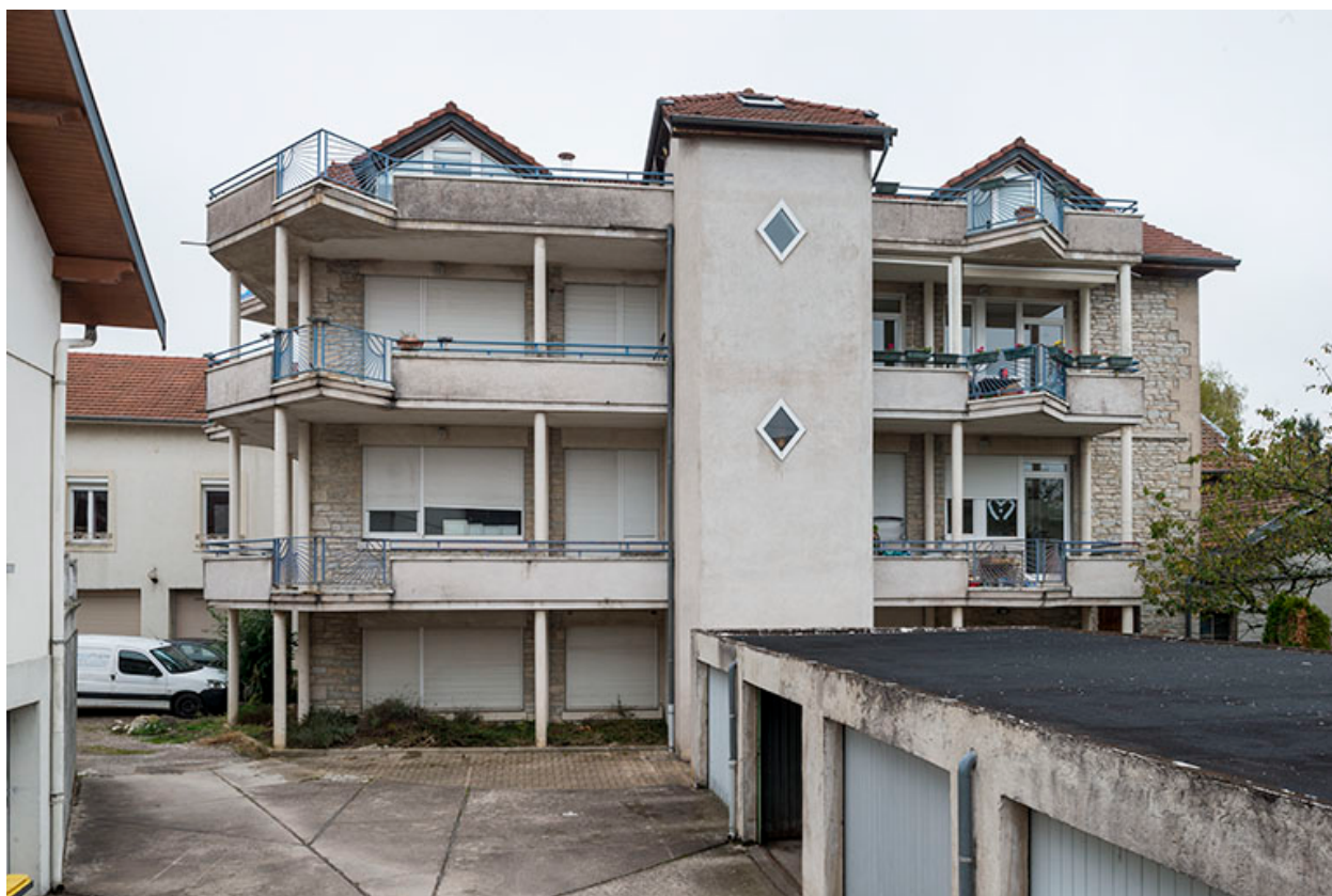
Façade ouest de l'atelier de fabrication.
