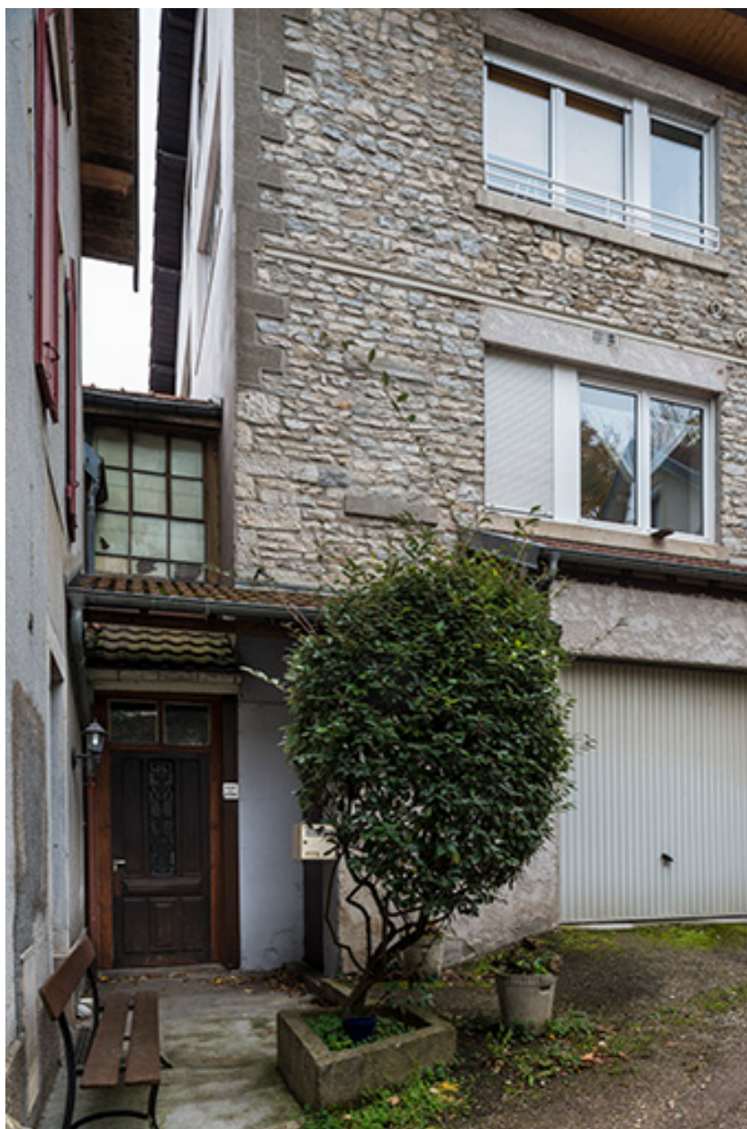
Extrémité sud de l'atelier de fabrication.
