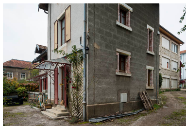
Logement, adossé au pignon sud de l'atelier.
