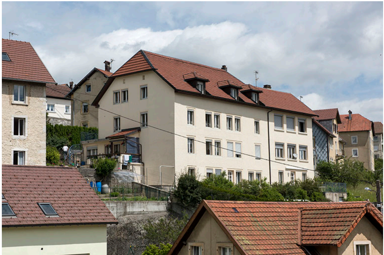
Façades postérieure et latérale gauche.
