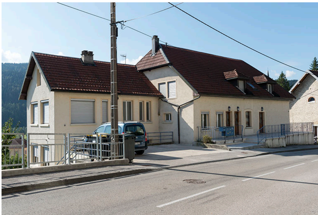
Façades antérieure et latérale gauche.
