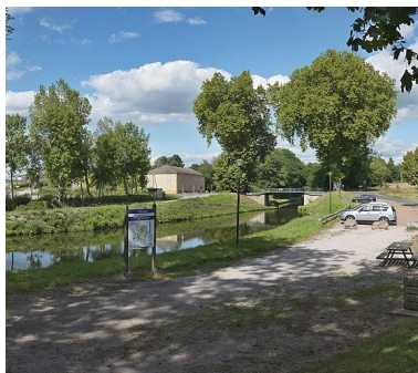
Le pont vu d'amont. Phot. Thierry Kuntz IVR26_20127100320NUC4A
