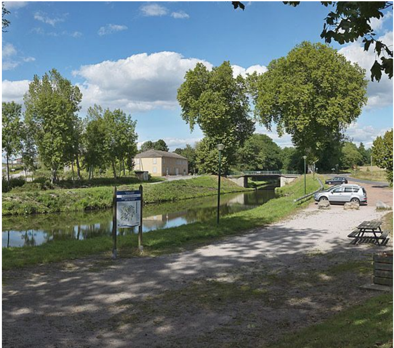
Le pont vu d'aval.
