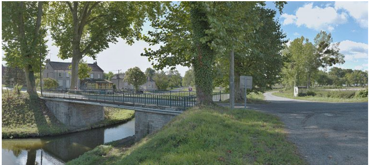
Le pont vu d'aval. Café en face.
