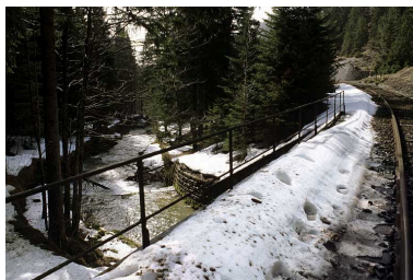
Garde-corps sud (aval) et ruisseau de l'Evalude canalisé. Phot. Yves Sancey IVR43_20053900376ZA
