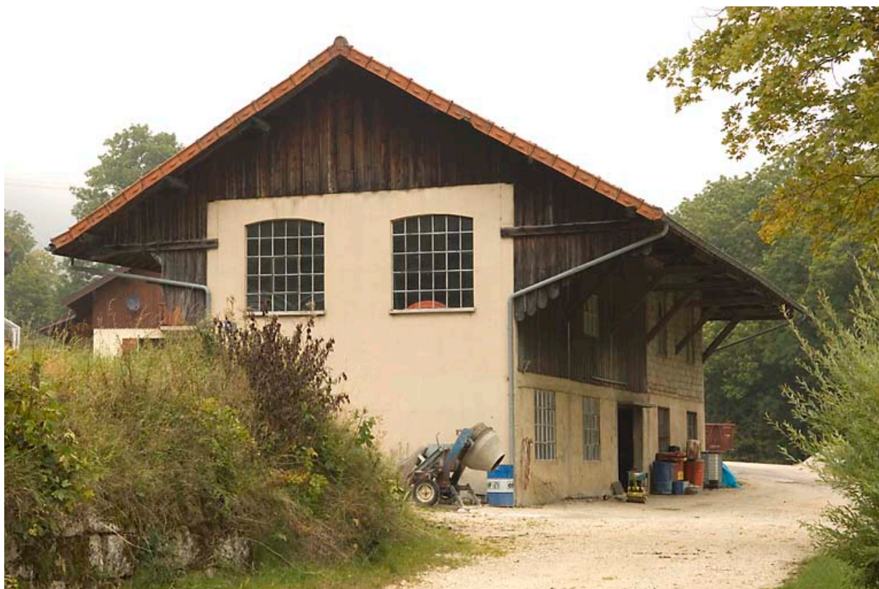
Vue rapprochée de la tonnellerie du côté de la Jougne.
