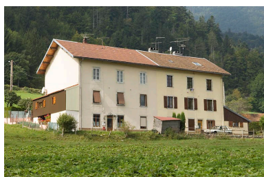
Immeuble à logements, façade postérieure. Phot. Jérôme Mongreville IVR43_20082501107NUC2A
