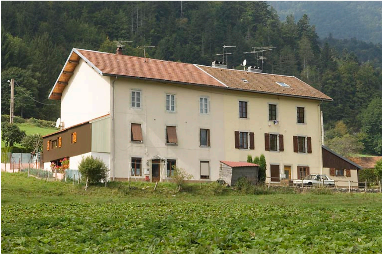
Immeuble à logements, façade postérieure.
