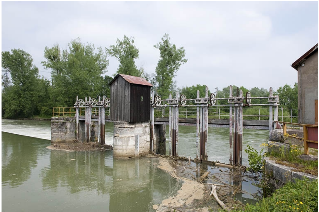
Vannage du barrage.
