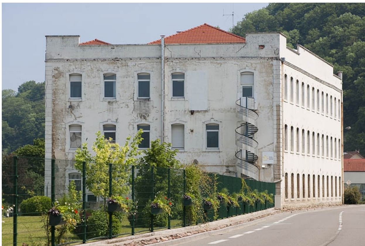
Immeuble de bureaux. Vue depuis le sud.
