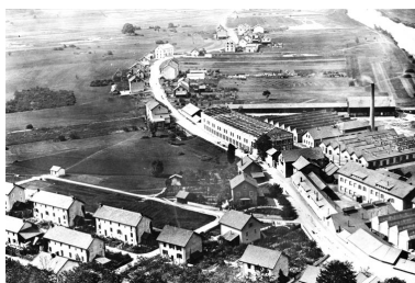
Extension de l'usine vers le sud. Photogr., s.n., s.d. [vers 1910]. Autr. IVR43_20122501510NUC2
