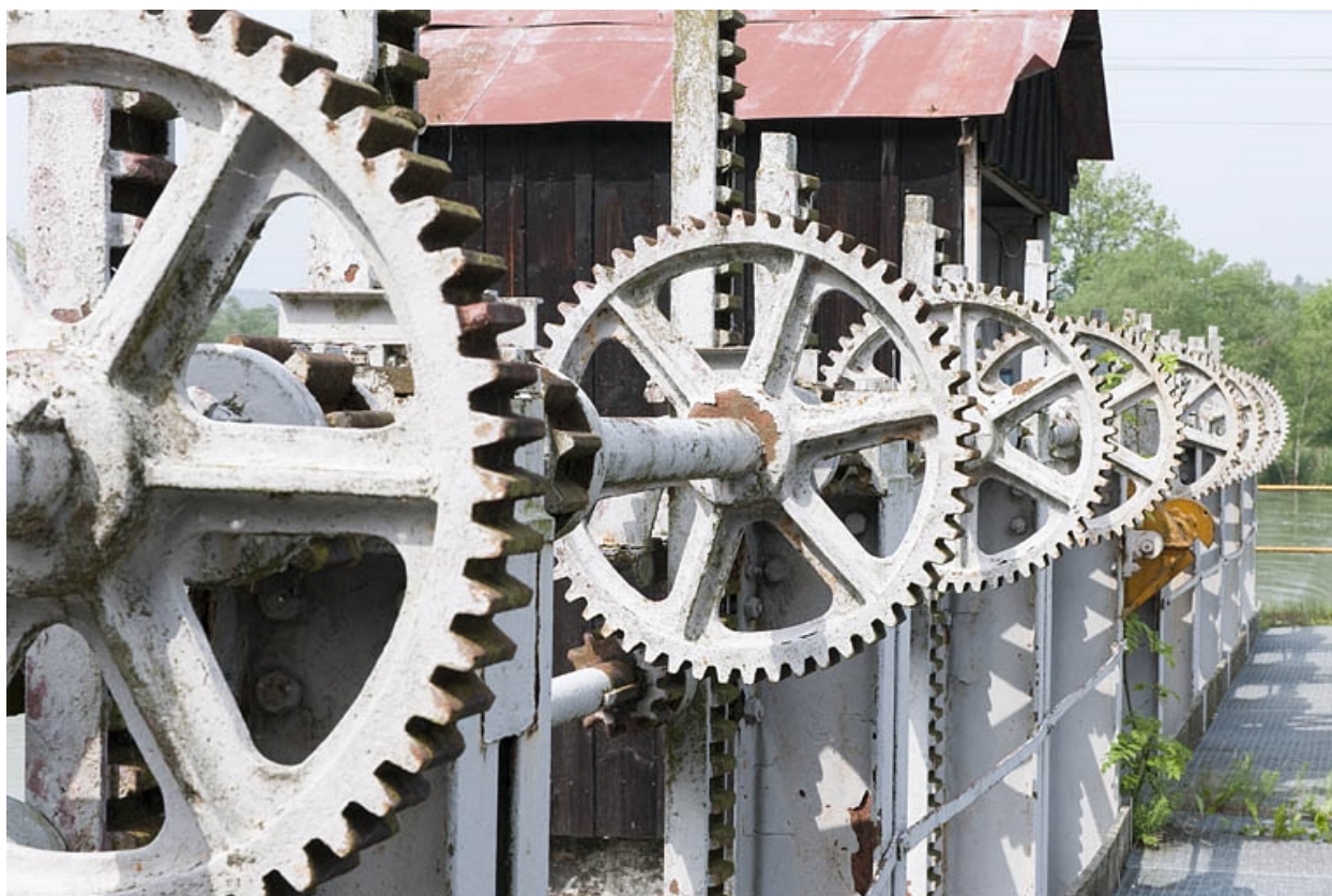
Vannage du barrage. Détail des engrenages.
