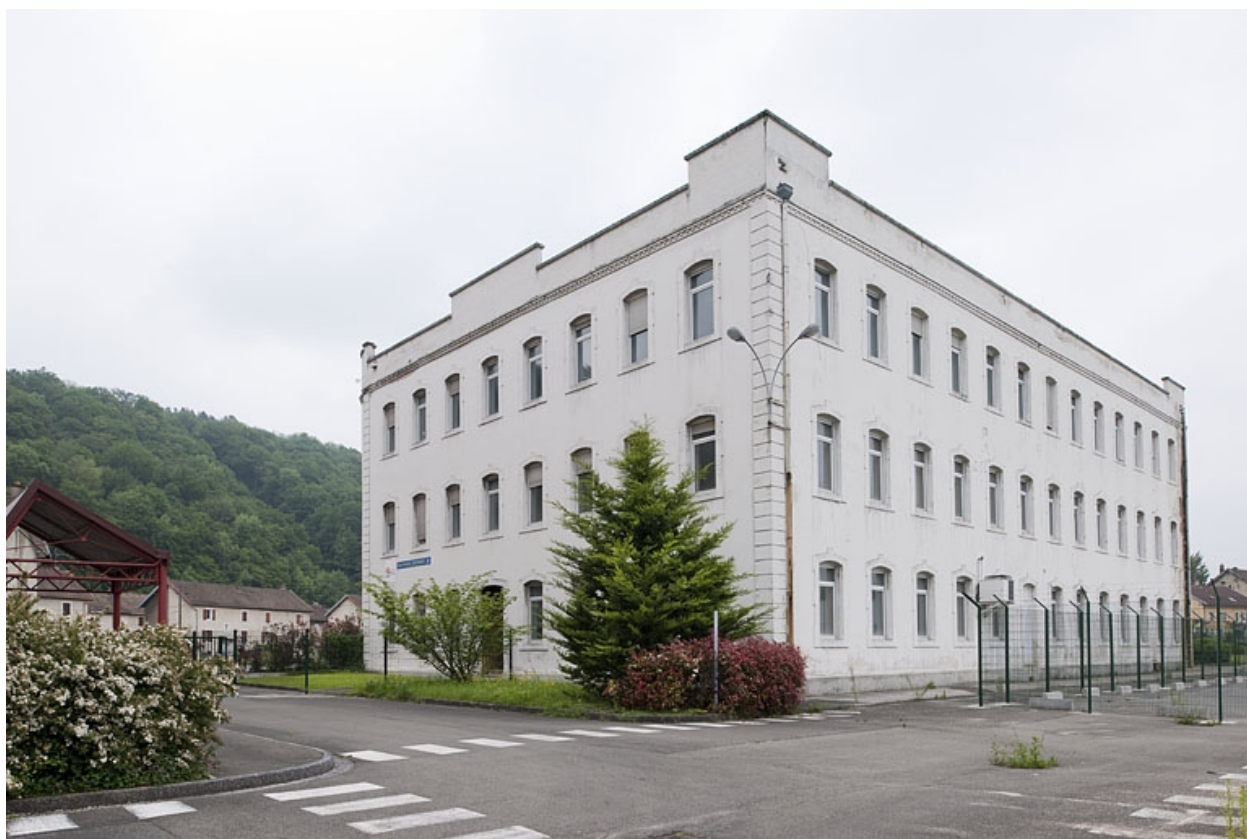
Immeuble de bureaux. Vue depuis le sud-ouest.
