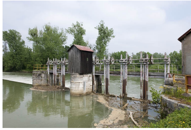
Vannage du barrage. Phot. Jérôme Mongreville IVR43_20122501095NUC4A
