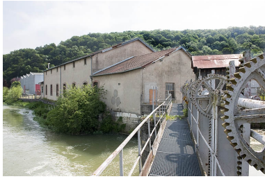
Bâtiment industriel depuis le barrage. Phot. Jérôme Mongreville IVR43_20122501097NUC4A
