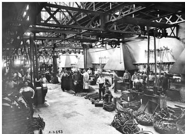
Atelier de forge (pièces pour cycles). Photogr., s.n., s.d. [1912 ?]. Autr. IVR43_20122501491NUC2
