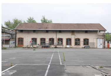
Bâtiment industriel. Vue de face.
