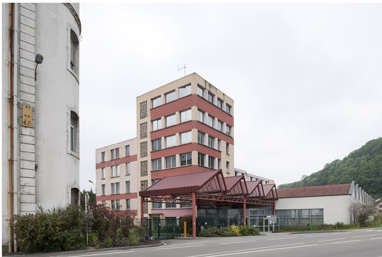
Bâtiments situés au nord de l'entrée.
