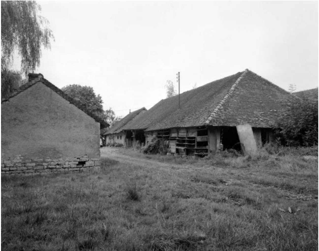
Atelier de fabrication depuis le nord.
