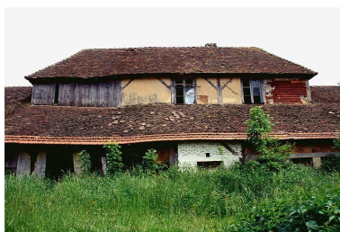
Façade ouest du logement d'ouvriers. Phot. Jérôme Mongreville IVR43_19963900506ZA
