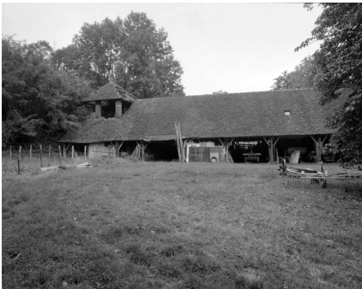
Four industriel et pièce de séchage.
