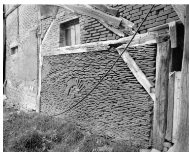
Façade ouest de l'écurie. Détail du pan-de-bois hourdé de tuiles et briques. Phot. Yves Sancey IVR43_19843900129X
