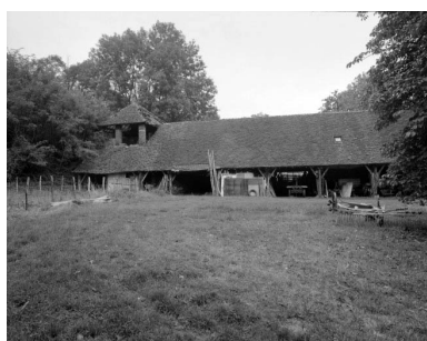
Four industriel et pièce de séchage. Phot. Yves Sancey IVR43_19843900132X
