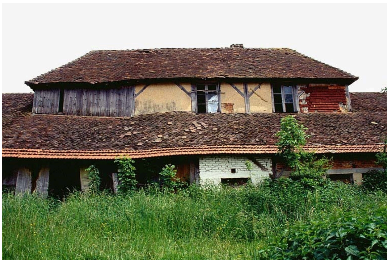
Façade ouest du logement d'ouvriers.
