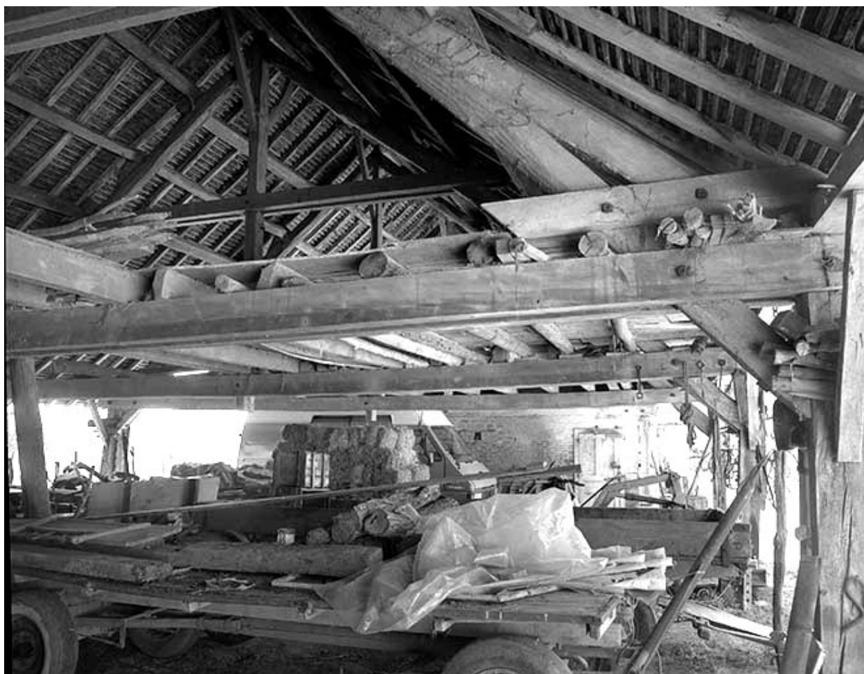
Vue intérieure de la pièce de séchage.
