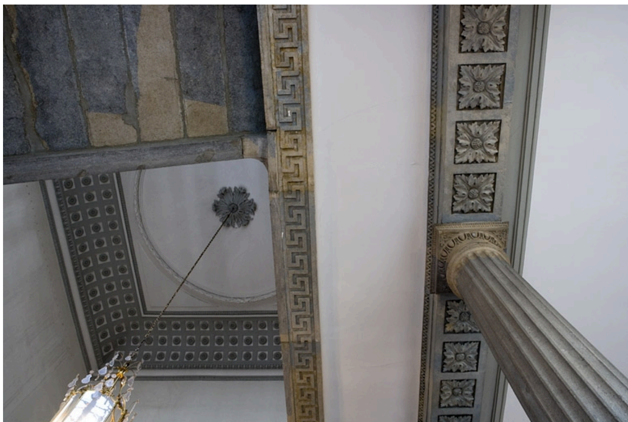
Détail du plafond à voussure de la cage d'escalier.
