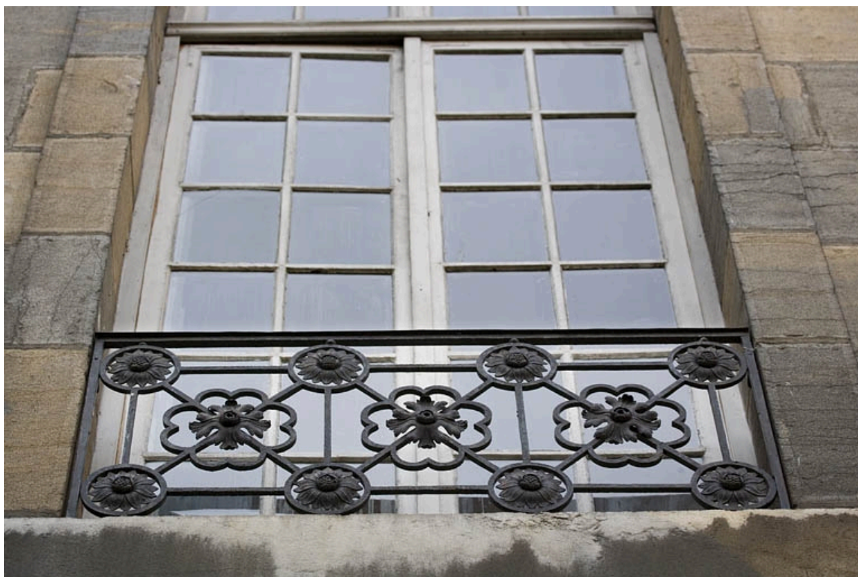
Détail de la ferronnerie d'un garde corps d'une fenêtre du logis principal au premier étage sur cour.
