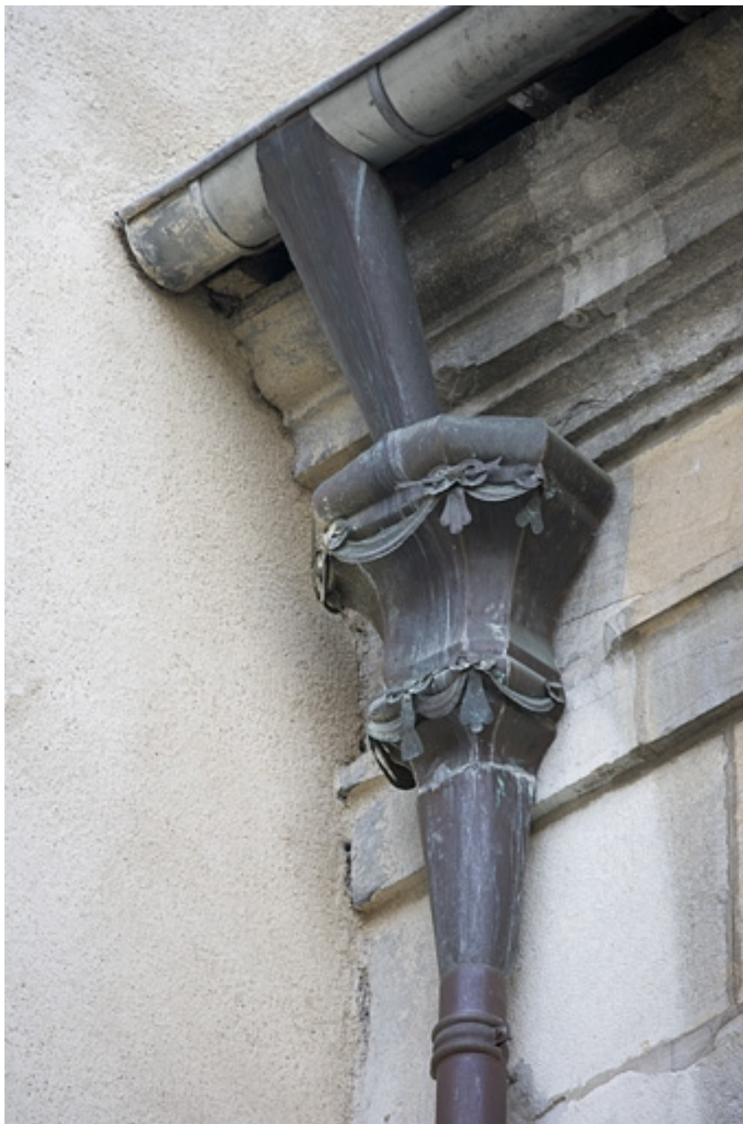
Détail d'une cuvette de descente des eaux sur la façade postérieure du logis principal.
