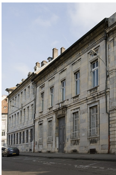
Vue d'ensemble de la façade sur rue, de trois quarts droit. Phot. Yves Sancey IVR43_20072500350NUCA
