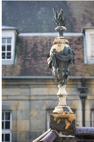
Détail d'un épi de faîtage sur le bâtiment droit des communs. Phot. Yves Sancey IVR43_20072500356NUCA
