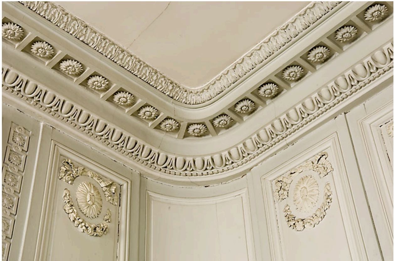
Détail d'un angle de la corniche du salon.
