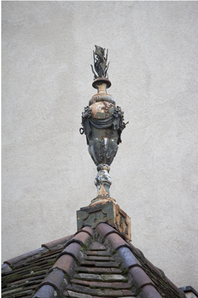
Détail d'un épi de faîtage sur l'une des toitures des communs.
