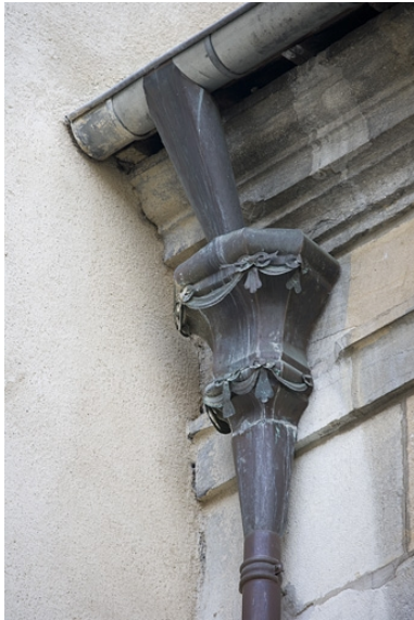
Détail d'une cuvette de descente des eaux sur la façade postérieure du logis principal. Phot. Yves Sancey IVR43_20072500352NUCA
