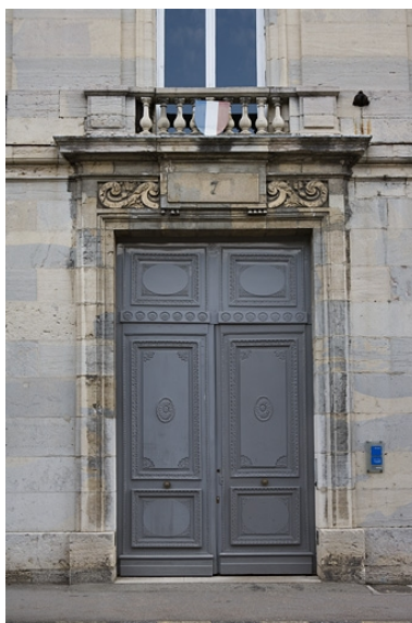
Détail du portail d'entrée. Phot. Yves Sancey IVR43_20072500349NUCA
