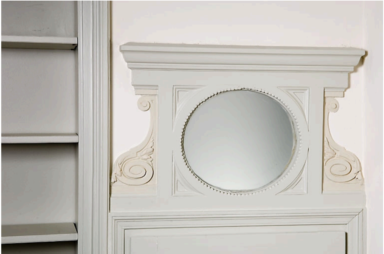
Détail du dessus de porte à droite de l'alcove : chambre à droite du salon.
