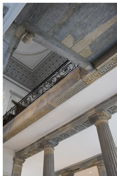
Détail du décor de l'entrée. Phot. Yves Sancey IVR43_20072500361NUCA
