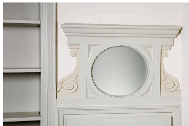
Détail du dessus de porte à droite de l'alcove : chambre à droite du salon. Phot. Jérôme Mongreville IVR43_20072500414NUCA
