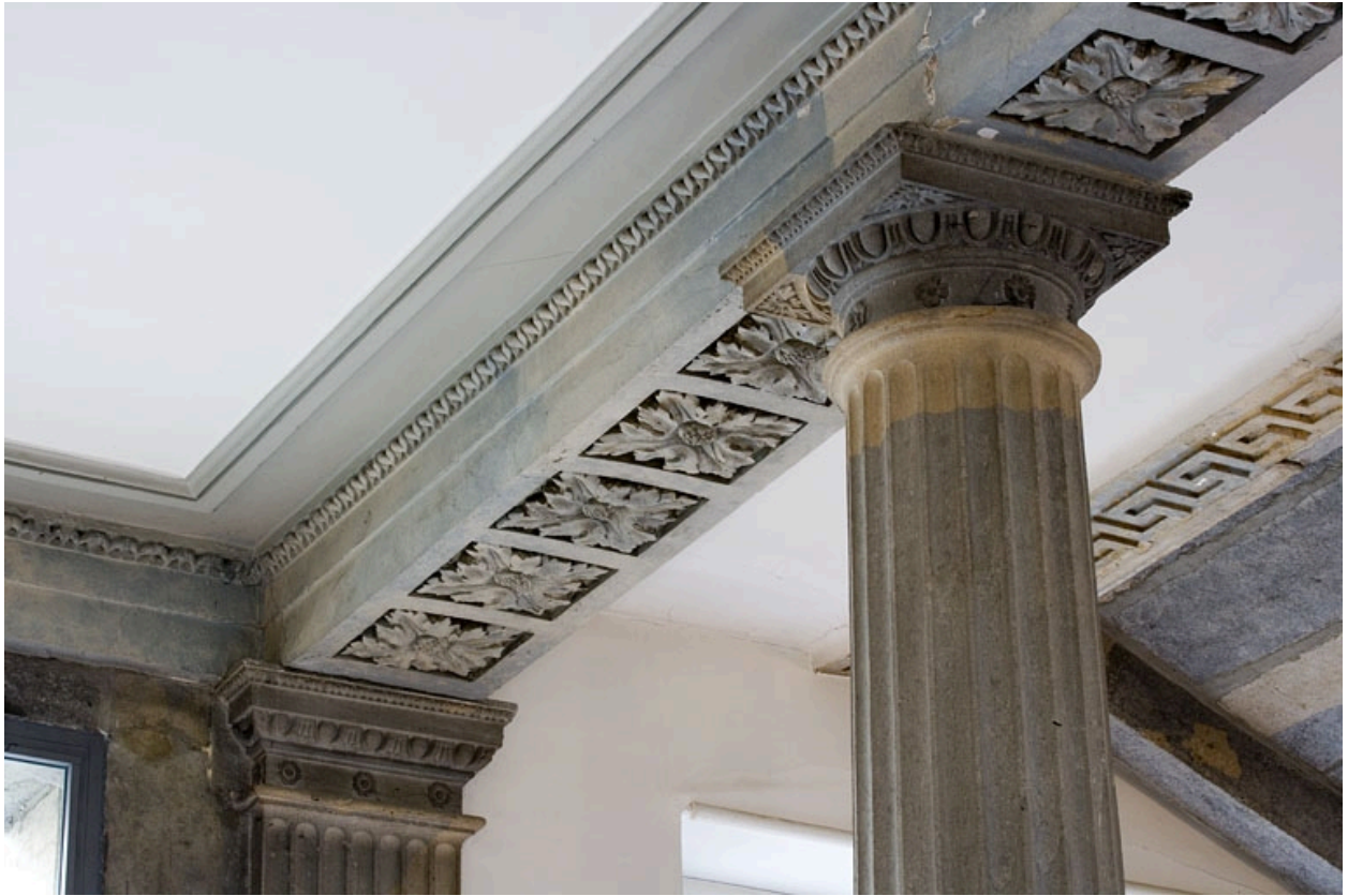
Détail des chapiteaux d'une colonne et d'un pilastre de l'entrée.
