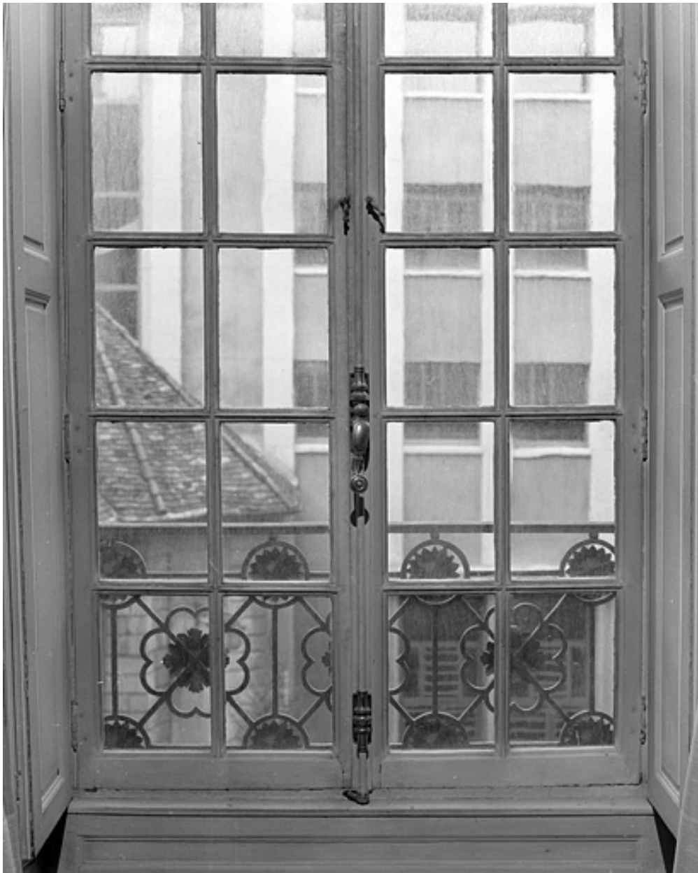
Détail d'une fenêtre à petits bois de l'antichambre.
