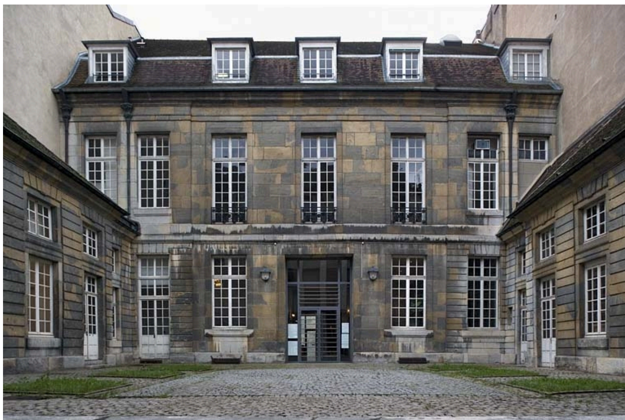
Vue d'ensemble de la façade sur cour du logis principal.
