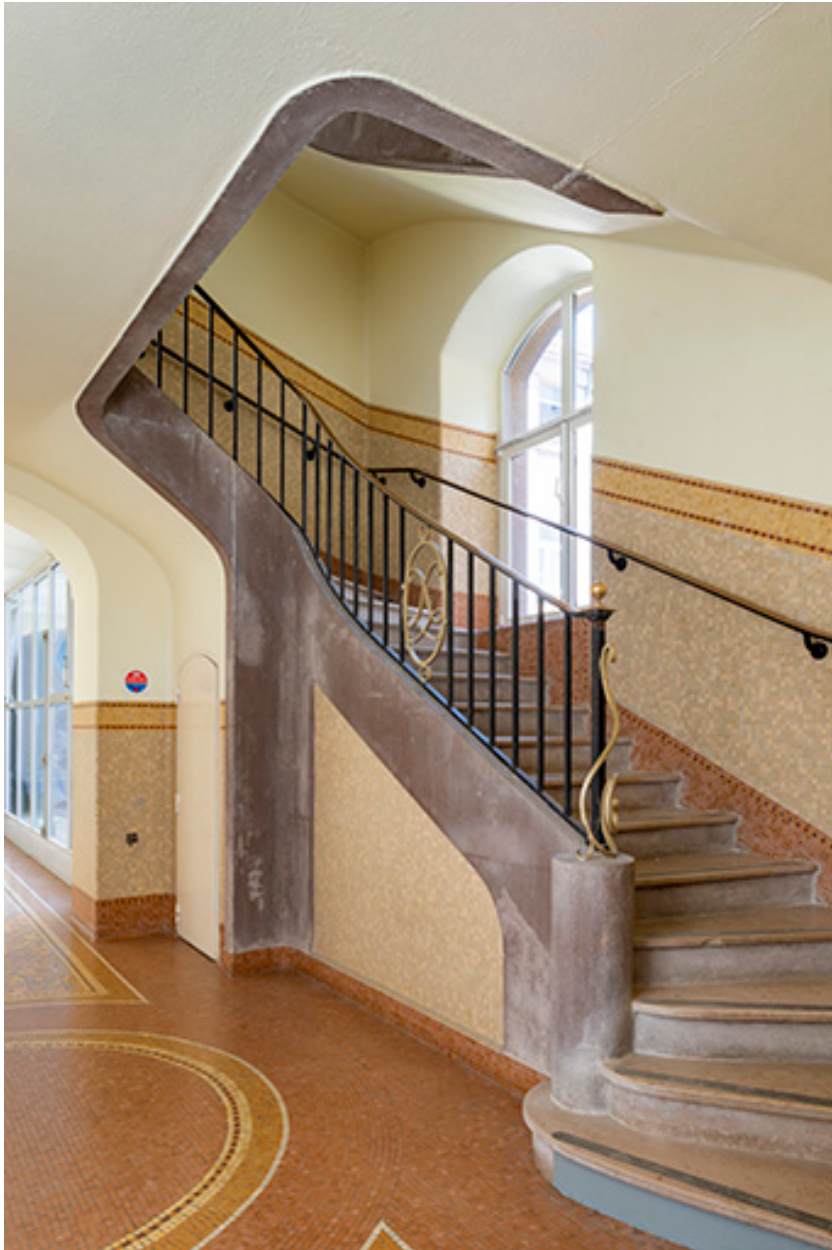
Escalier à garde-corps métallique orné d'un médaillon ovale au chiffre de Luxeuil.
