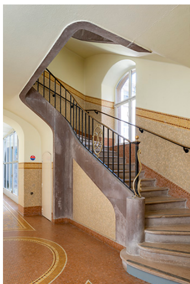
Escalier à garde-corps métallique orné d'un médaillon ovale au chiffre de Luxeuil. Phot. Jérôme Mongreville IVR43_20207000236NUC4A
