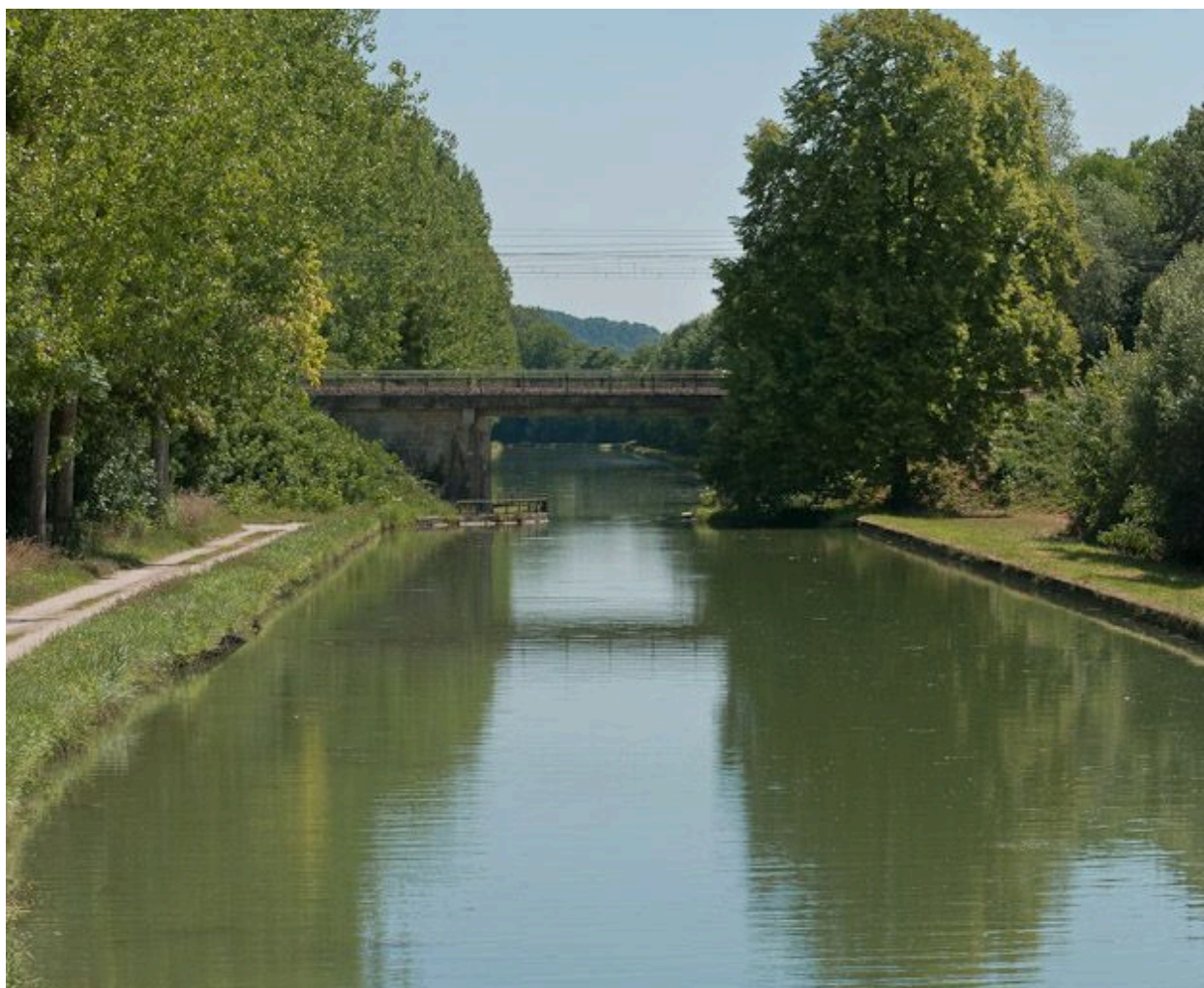
Vue du pont.
