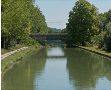
Vue du pont.
