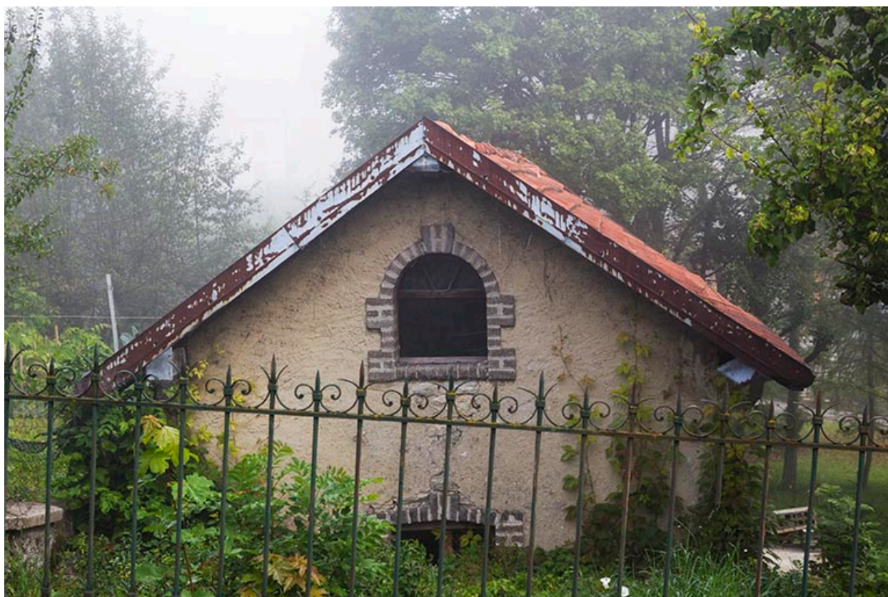
Bûcher : pignon sud.
