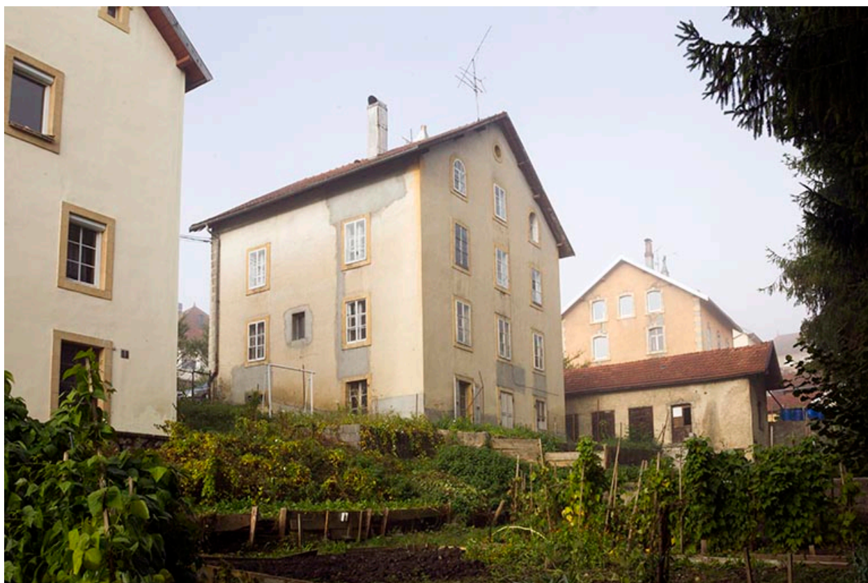
Façades postérieure et latérale droite.
