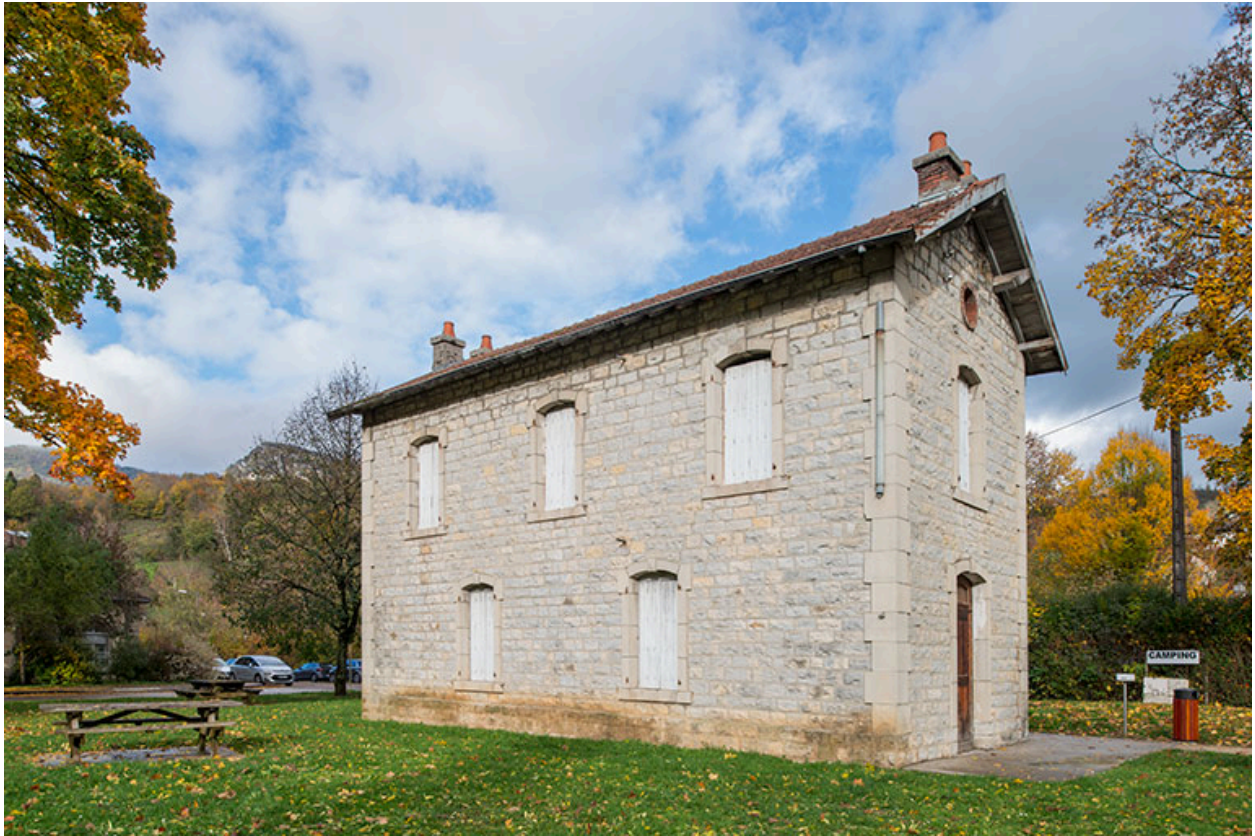
Vue de trois quarts depuis le sud-ouest.
