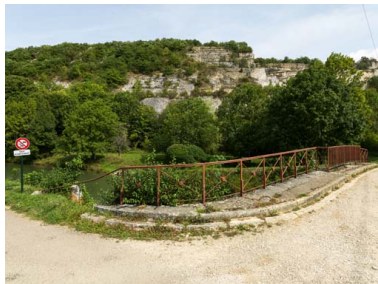
Vue d'ensemble depuis le pont de l'écluse.
