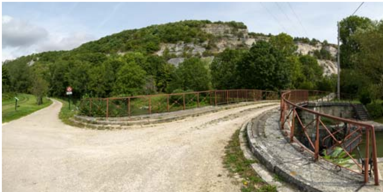
Vue d'ensemble depuis le pont de l'écluse. Sur la droite, bâtiments de la carrière.
