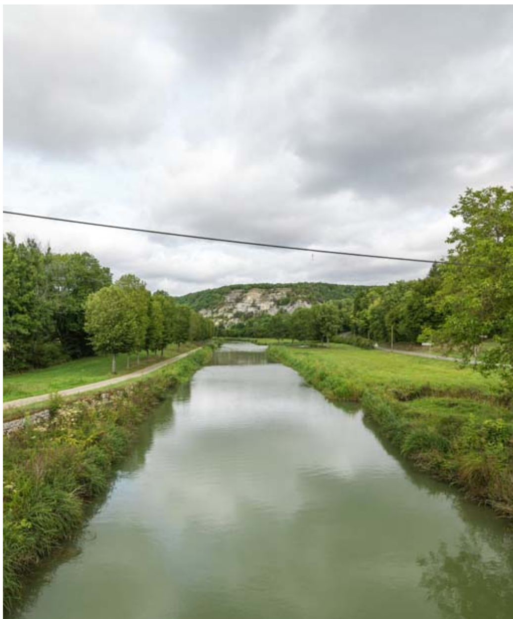
Vue d'ensemble depuis le pont de la D228.
