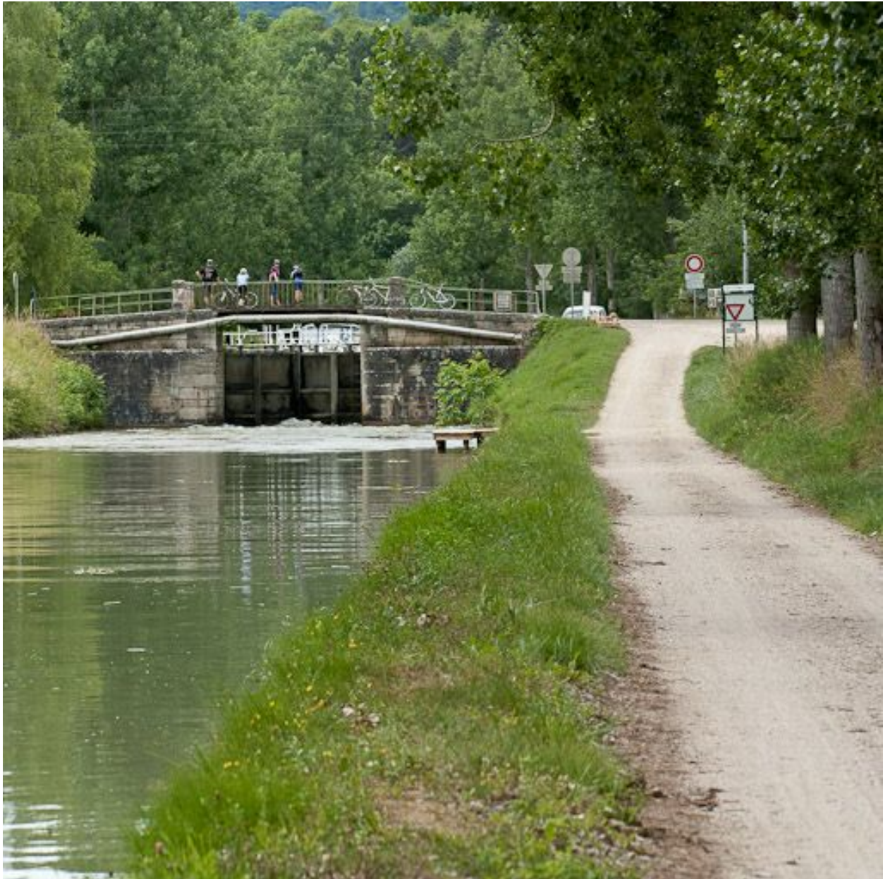
Vue du pont sur écluse.
