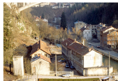
Vue d'ensemble depuis l'ouest. Phot. Laurent Poupard IVR43_19923901398ZA
