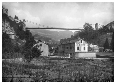
[Vue d'ensemble depuis le nord-ouest]. Phot. Jérôme Mongreville, Phot. Jules Manias IVR43_19963900167XI
