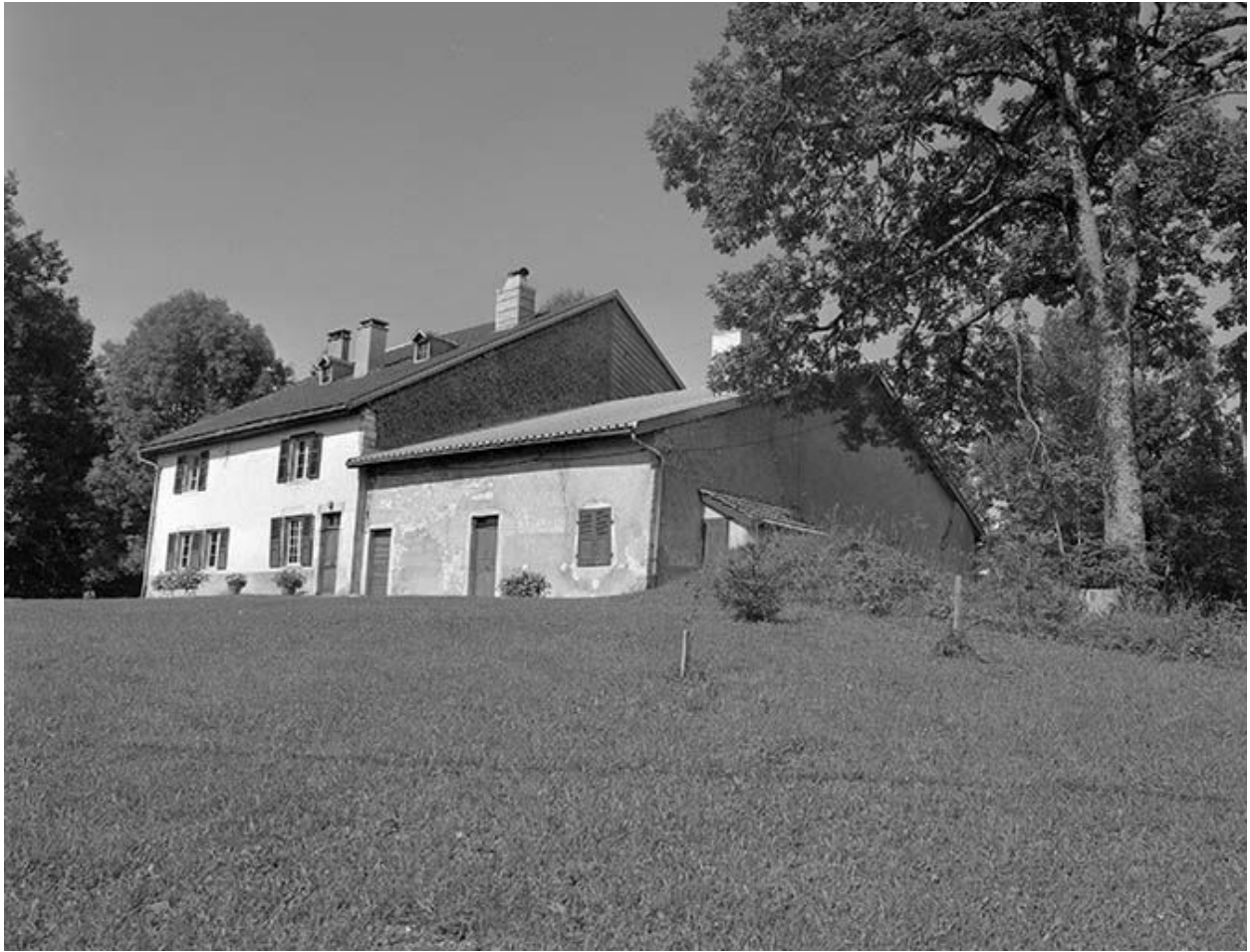
Ferme située au lieudit Les Petits Valets.
