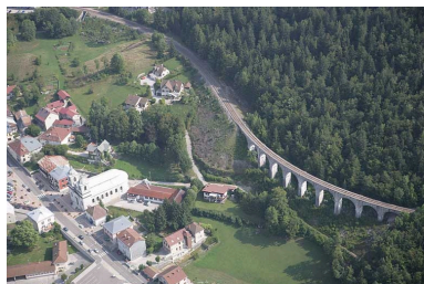
Viaduc de Morbier situé au lieudit Le Bois des Crottes. Phot. Jean-Pierre Bévalot IVR43_20053900993NUCA
