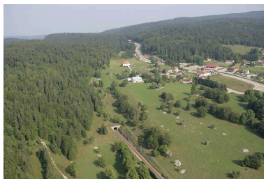
Tunnel dit souterrain de la Savine situé au lieudit Le Bois de la Savine. Phot. Jean-Pierre Bévalot IVR43_20053900964NUCA
