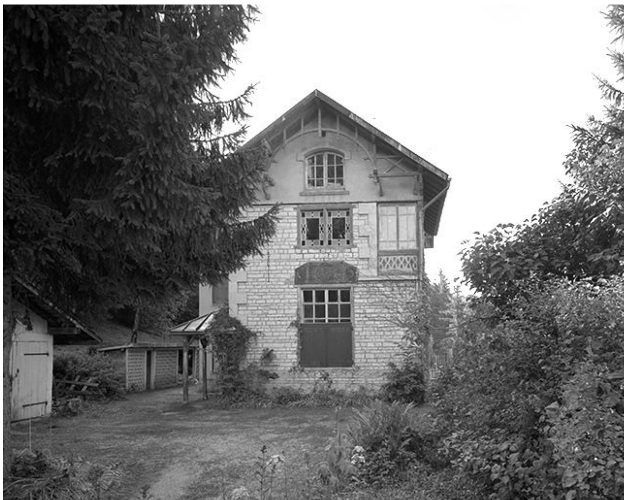
Maison située 11 Côte à la Luce.
