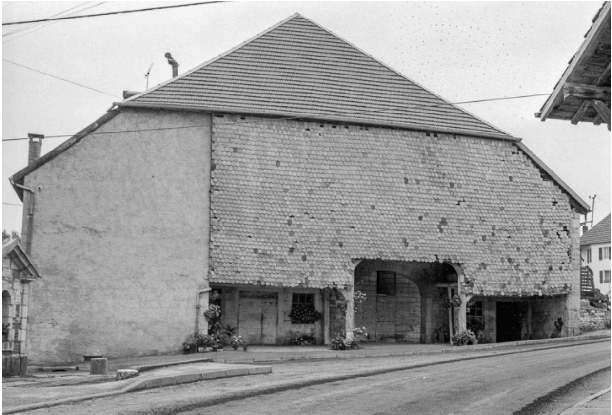
Façade latérale droite sur rue.
