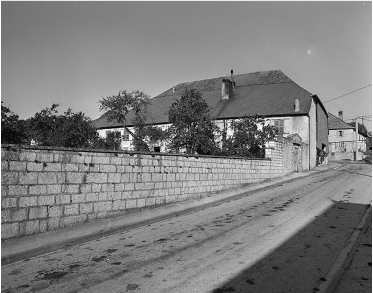
Façade antérieure et mur d'enclos.
