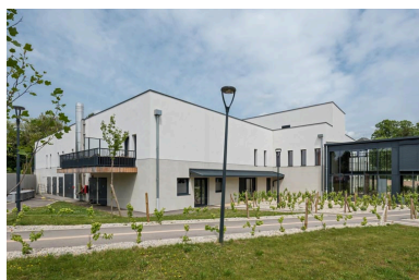
Vue depuis le sud.
