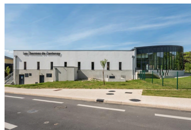
Vue depuis le nord-est.
