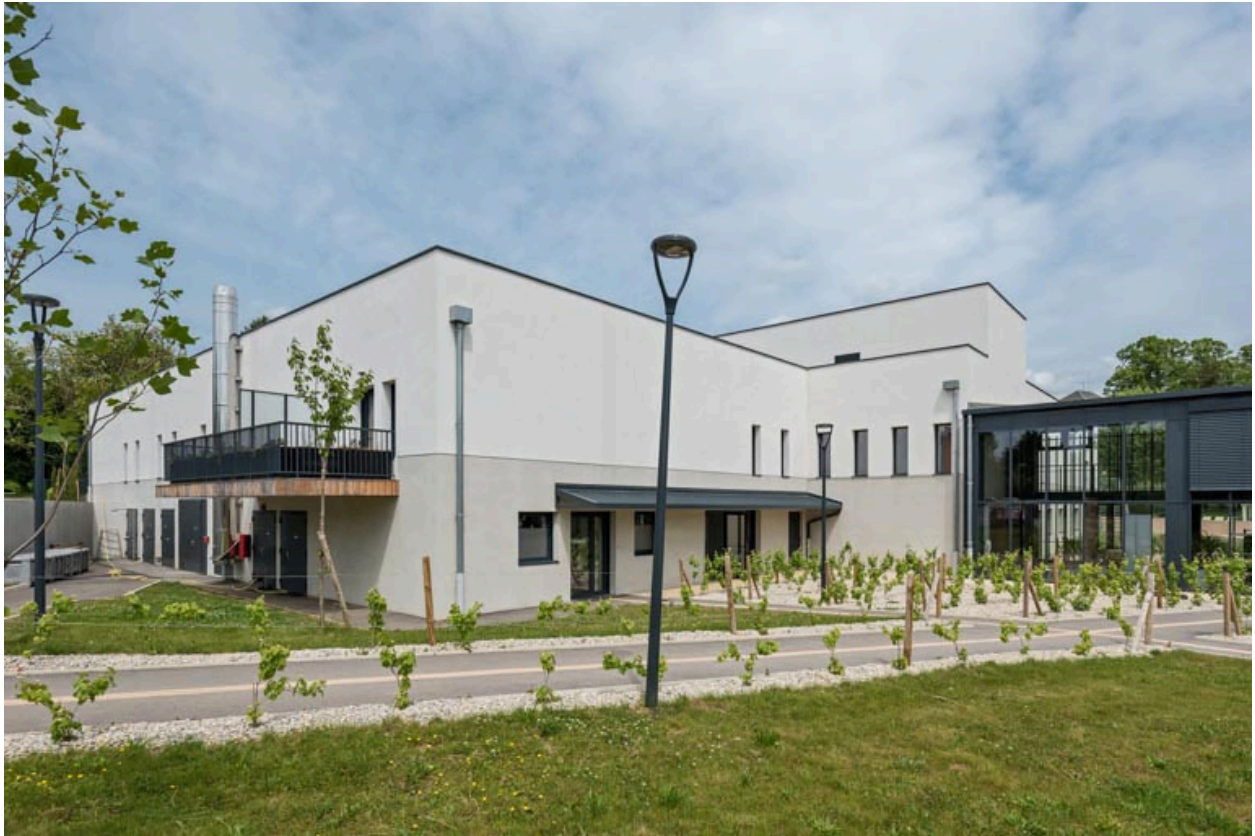
Vue depuis le sud.
