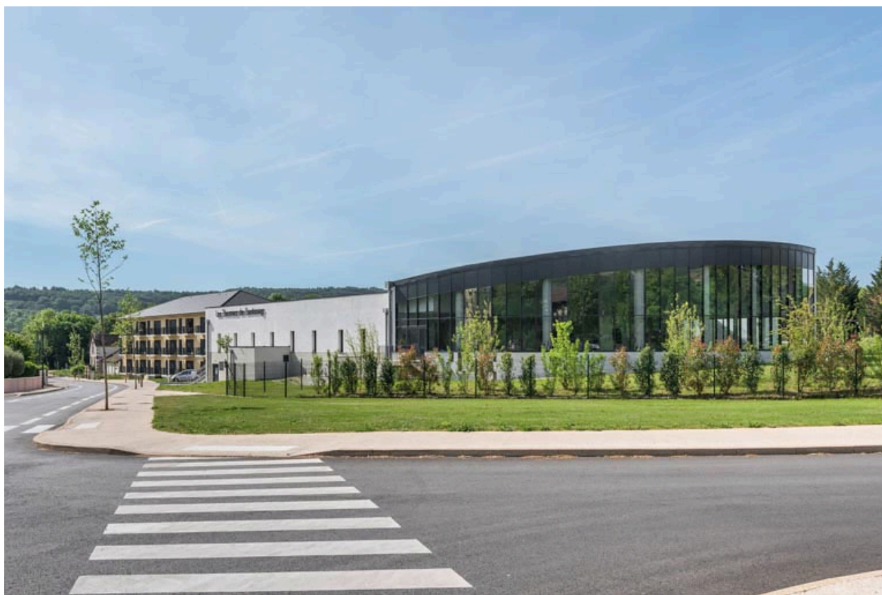
Vue depuis le nord.
