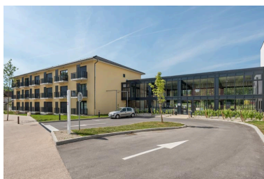
Vue depuis le nord-est : le hall d'entrée (à droite) et l'hôtel (à gauche).
