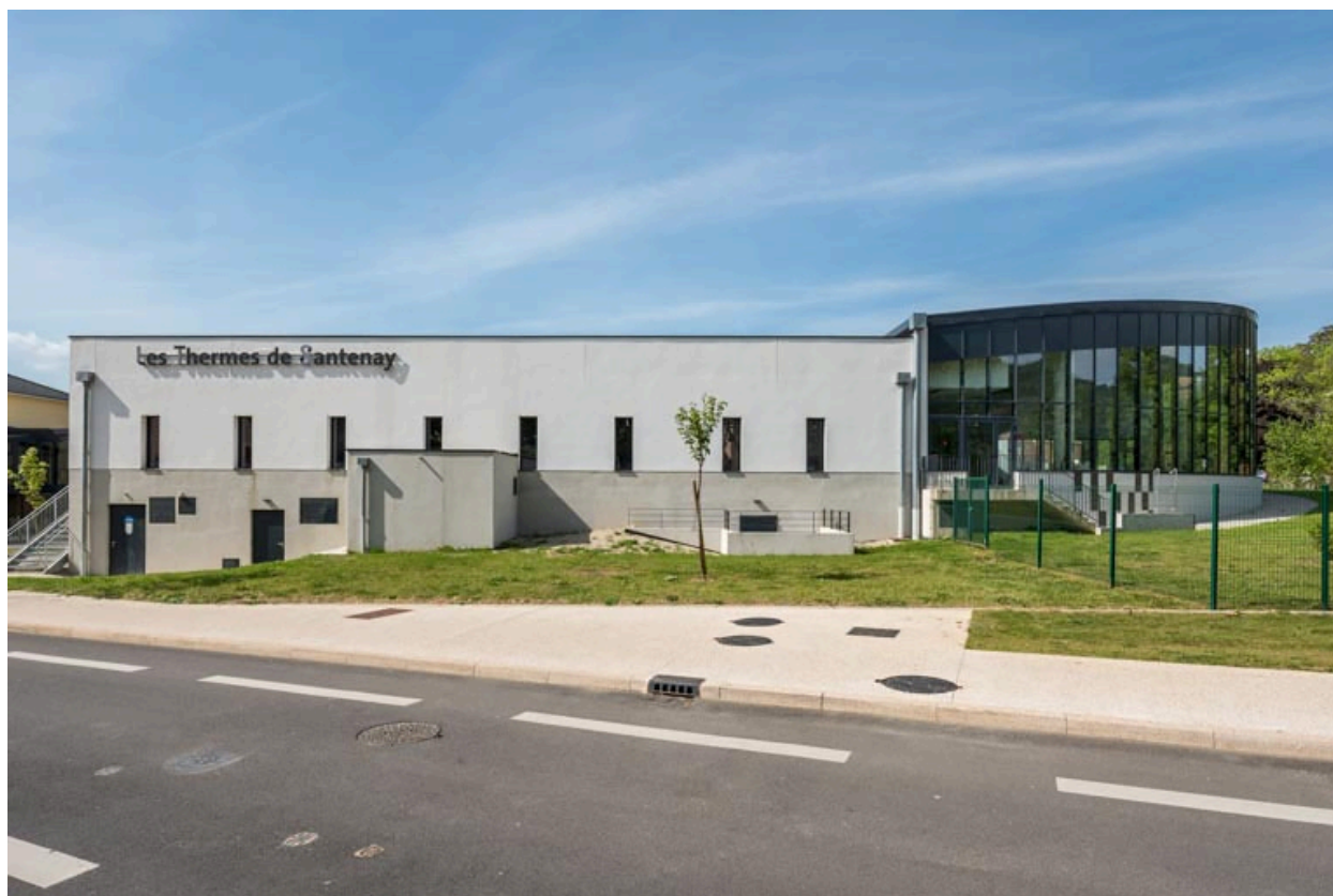
Vue depuis le nord-est.
