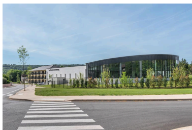
Vue depuis le nord.
