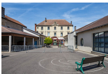
Vue d'ensemble de la cour et du bâtiment principal. Phot. Jérôme Mongreville IVR43_20217000392NUC4A
