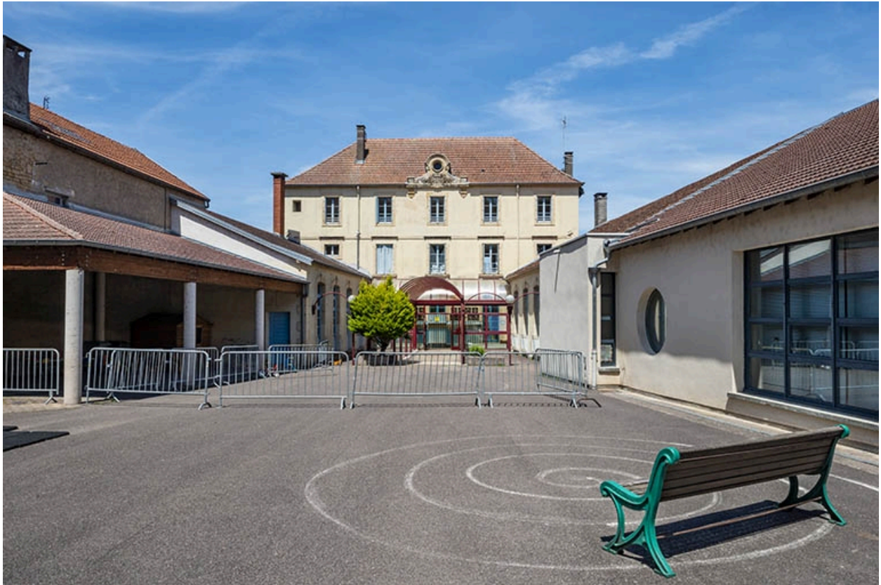
Vue d'ensemble de la cour et du bâtiment principal.
