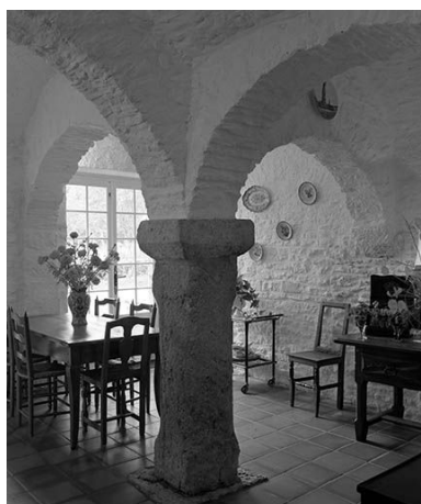
Scey-Maisières : maison située à Scey-en-Varais avec cuisine à voûtes d'arêtes reposant sur un pilier central.
