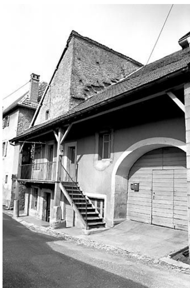
Ornans : maison de polyculteur de vallée située 9 rue de la Froidière. Phot. Yves Sancey IVR43_19772500078X
