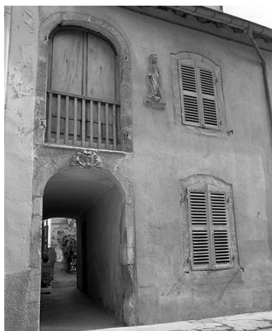
Mouthier-Haute-Pierre : maison de vigneron située 30 Grande Rue, à un étage carré, avec grenier au-dessus du passage couvert conduisant au jardin et décor rapporté. Phot. Yves Sancey IVR43_19802501108X
