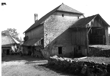
Tarcenay, les Rubis : ferme avec écurie et pont de grange sur le mur pignon. Phot. Gilbert Poinot IVR43_19762500861Z
