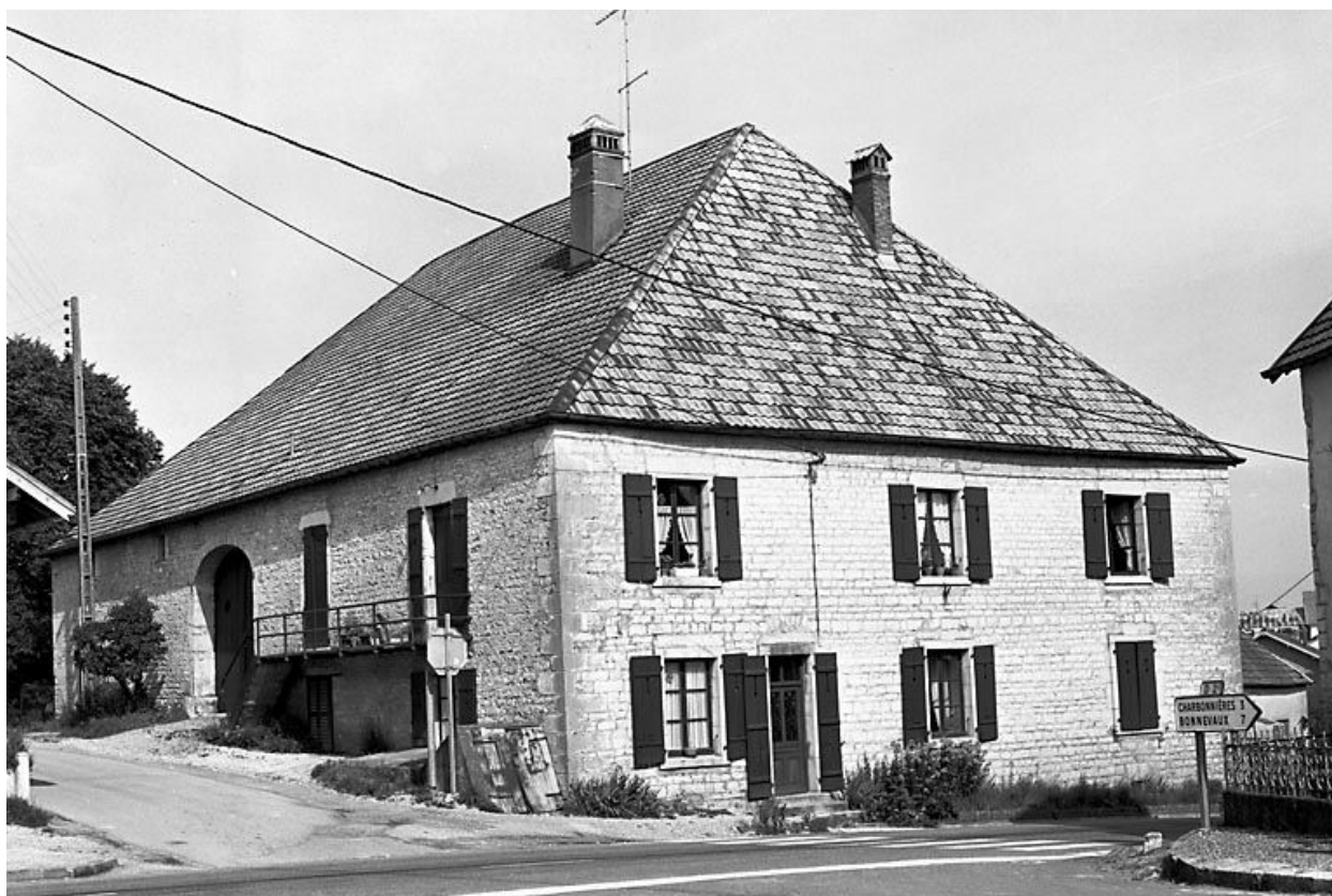
L'Hôpital-du-Grosbois : exemple de ferme bloc abritant deux logis et les parties agricoles sous le même toit.
