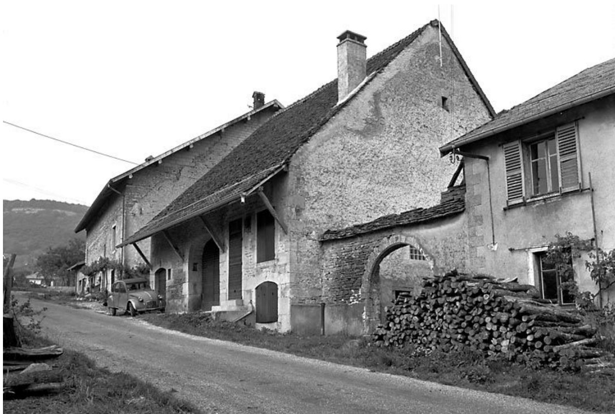
Façade antérieure vue de trois quart droit.
