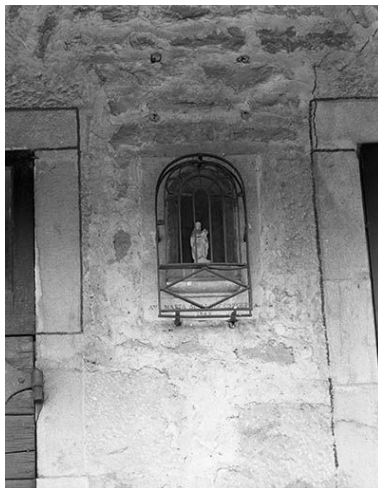
La niche ornant la façade antérieure. Phot. Yves Sancey IVR43_19812500272X
