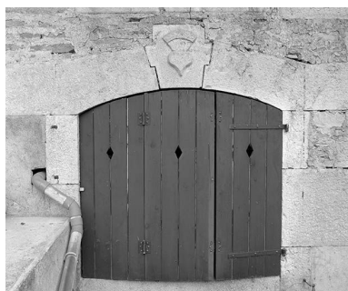
Façade antérieure : linteau de la baie éclairant le sous-sol. Phot. Yves Sancey IVR43_19802501140X
