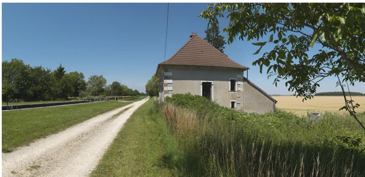
Maison éclusière vue du côté gauche.
