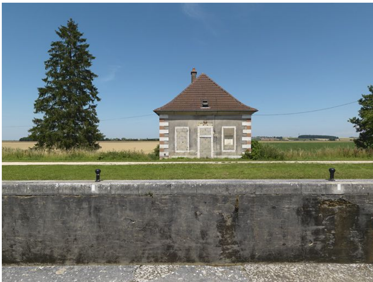
Maison éclusière : vue de face.
