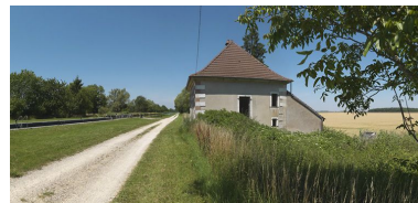
Maison éclusière vue du côté gauche. Phot. Thierry Kuntz IVR26_20112103193NUC4A
