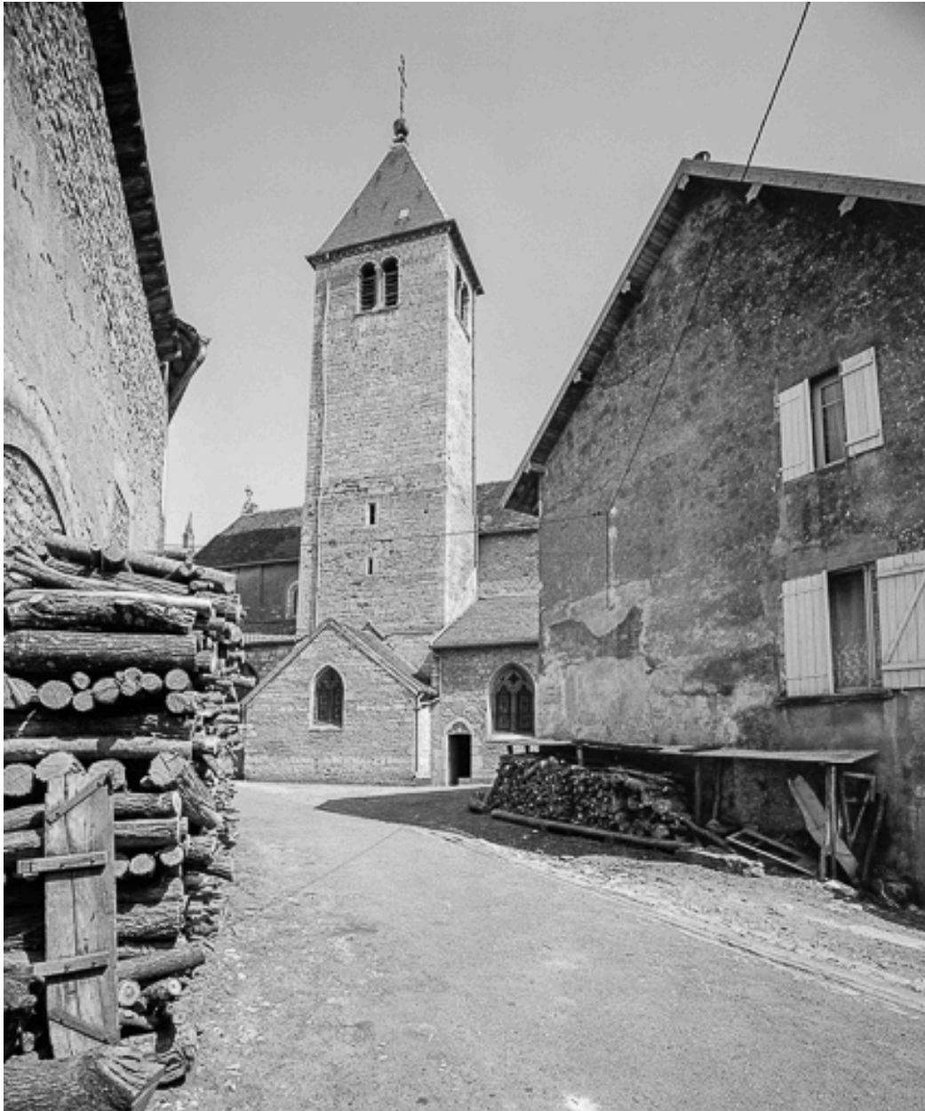
Façade latérale droite.
