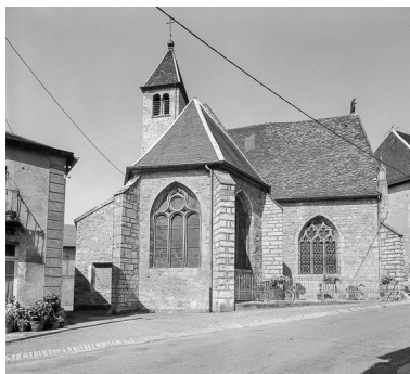
Façade postérieure. Phot. Bernard Lardière IVR43_19767000795V
