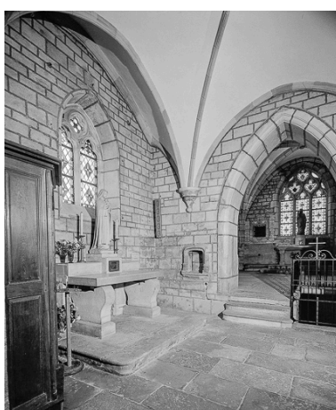
Bas côté gauche (avant la chapelle gauche). Phot. Bernard Lardière IVR43_19767000807V
