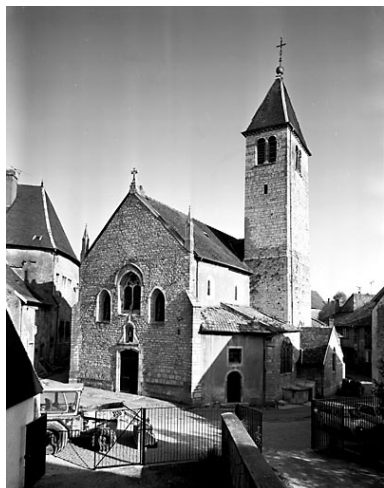
Vue des façades ouest et sud. Phot. Yves Sancey IVR43_19837000221V
