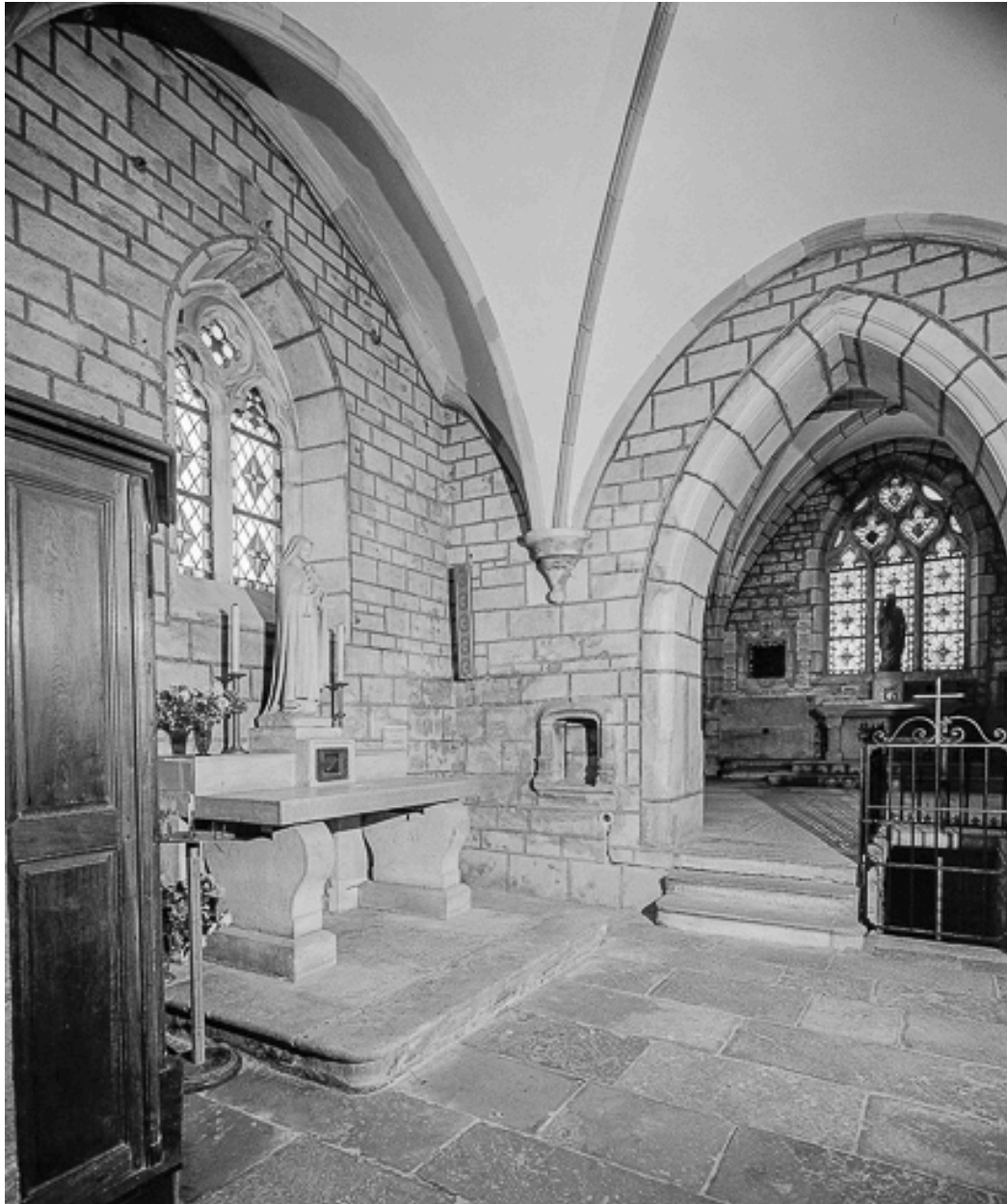
Bas côté gauche (avant la chapelle gauche).
