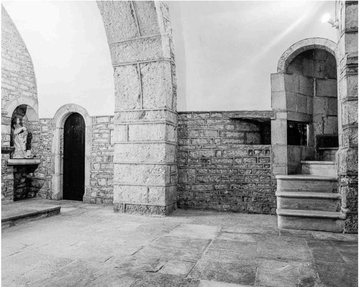
Bas côté droit, deuxième travée, mur ouest.
