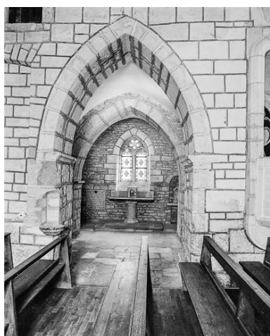
Chapelle, bas côté droit, deuxième travée, mur sud. Phot. Bernard Lardière IVR43_19767000812X
