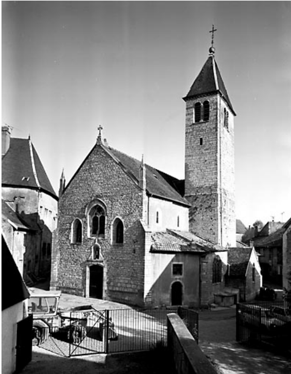
Vue des façades ouest et sud.
