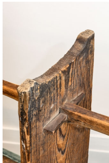
Banc rembourré rustique : détail de l'assemblage de la traverse inférieure. Phot. Pierre-Marie Barbe-Richaud IVR26_20222100595NUC4A
