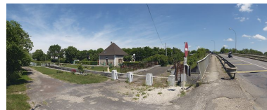
Vue d'ensemble du site et du pont : le pont ancien a été doublé d'un pont moderne.
