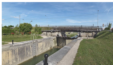
Le sas avec le pont vu d'amont.
