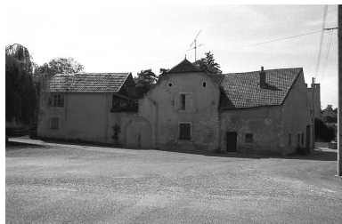
Vue d'ensemble. Phot. Bernard Lardière IVR43_19817000496Z
