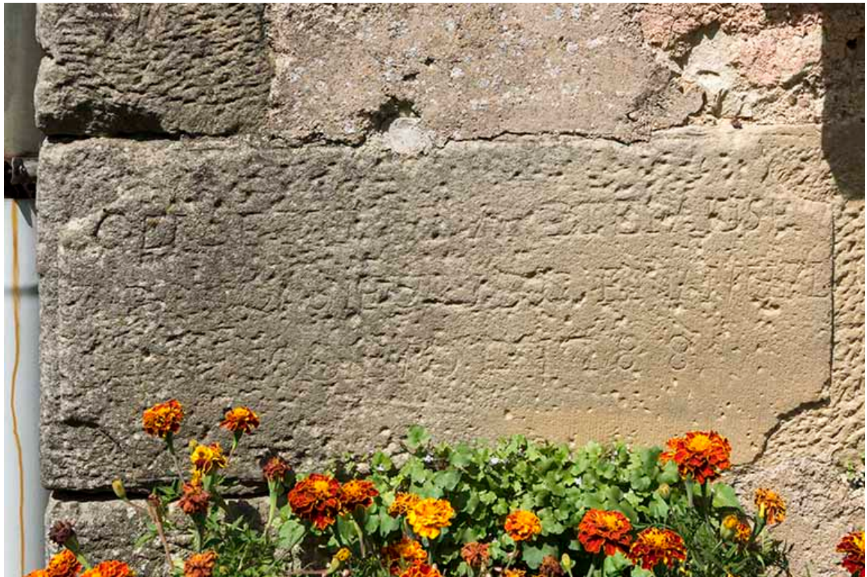
Détail : pierre de fondation (1788) (ancien moulin)
