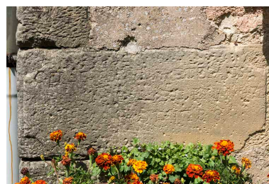
Détail : pierre de fondation (1788) (ancien moulin) Phot. Sonia Dourlot IVR43_20167001263NUC4A
