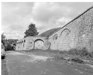
Créneaux de pied défendant l'enceinte : vue éloignée. Phot. Yves Sancey IVR43_19802500564X
