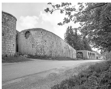
Entrée du fort et créneaux de pied. Phot. Yves Sancey IVR43_19802500560X
