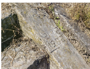
Escaliers du barrage avec le détail de la date de la crue. Phot. Thierry Kuntz IVR26_20162101335NUC4A
