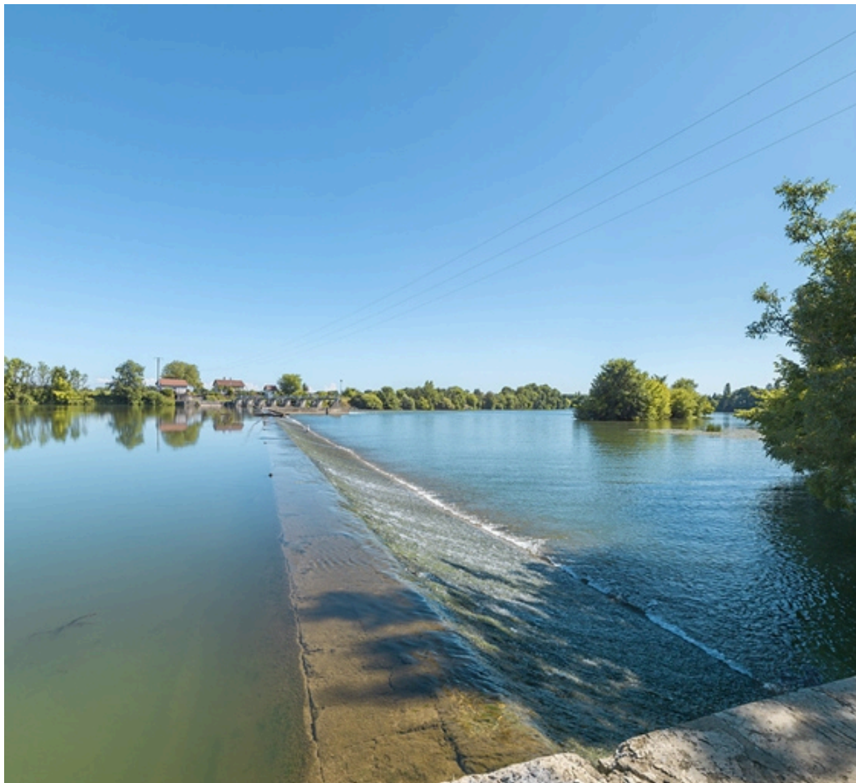
Le déversoir du barrage.
