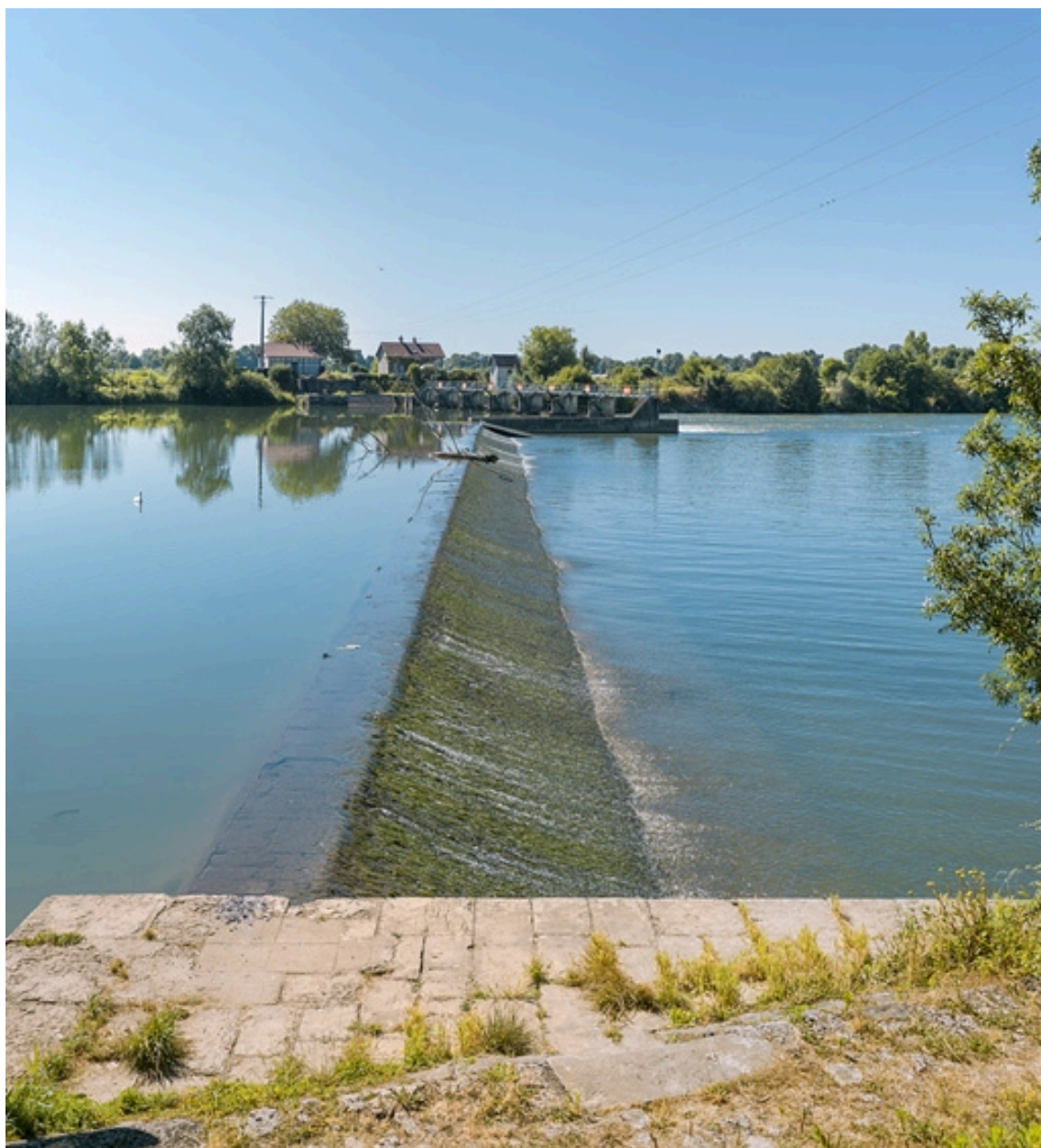
Le déversoir du barrage.
