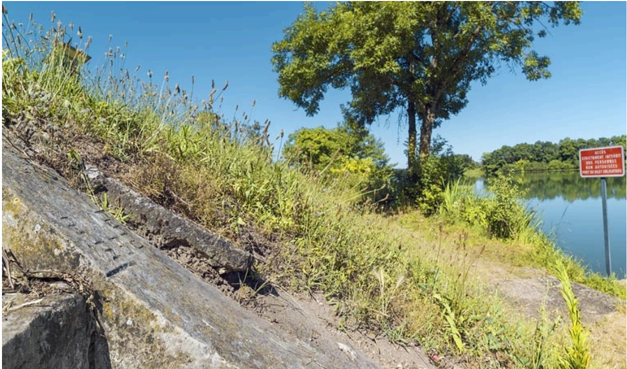
Escaliers du barrage : détail de la date de la crue.
