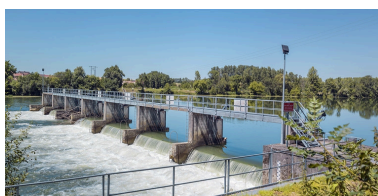
Barrage et ses vérins hydrauliques depuis la rive gauche. Phot. Thierry Kuntz IVR26_20162101331NUC4A
