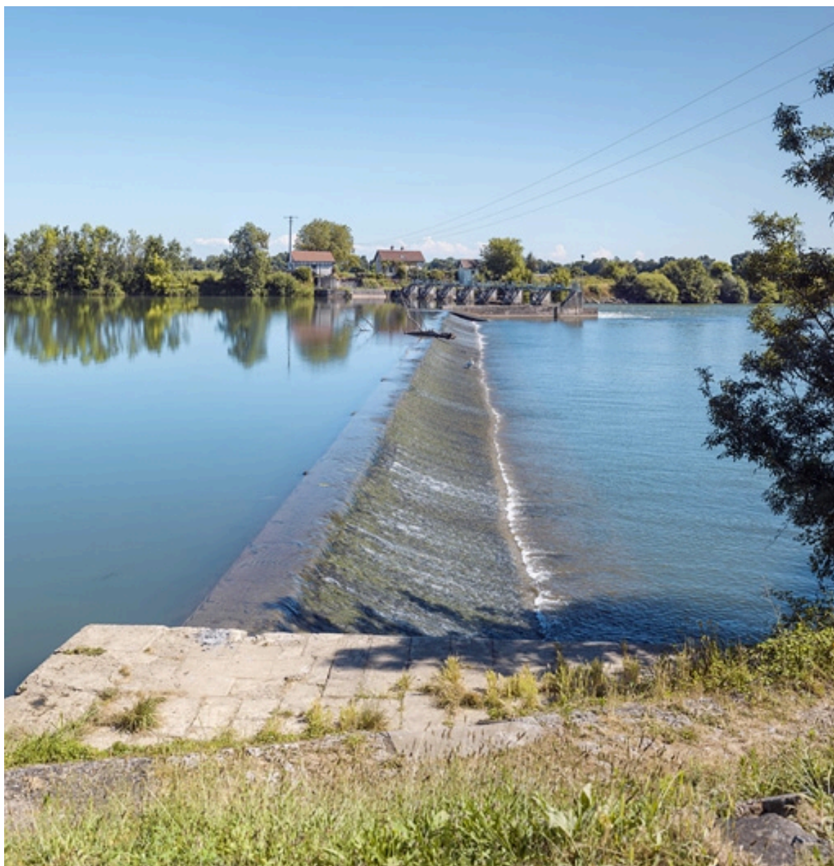
Le déversoir du barrage.
