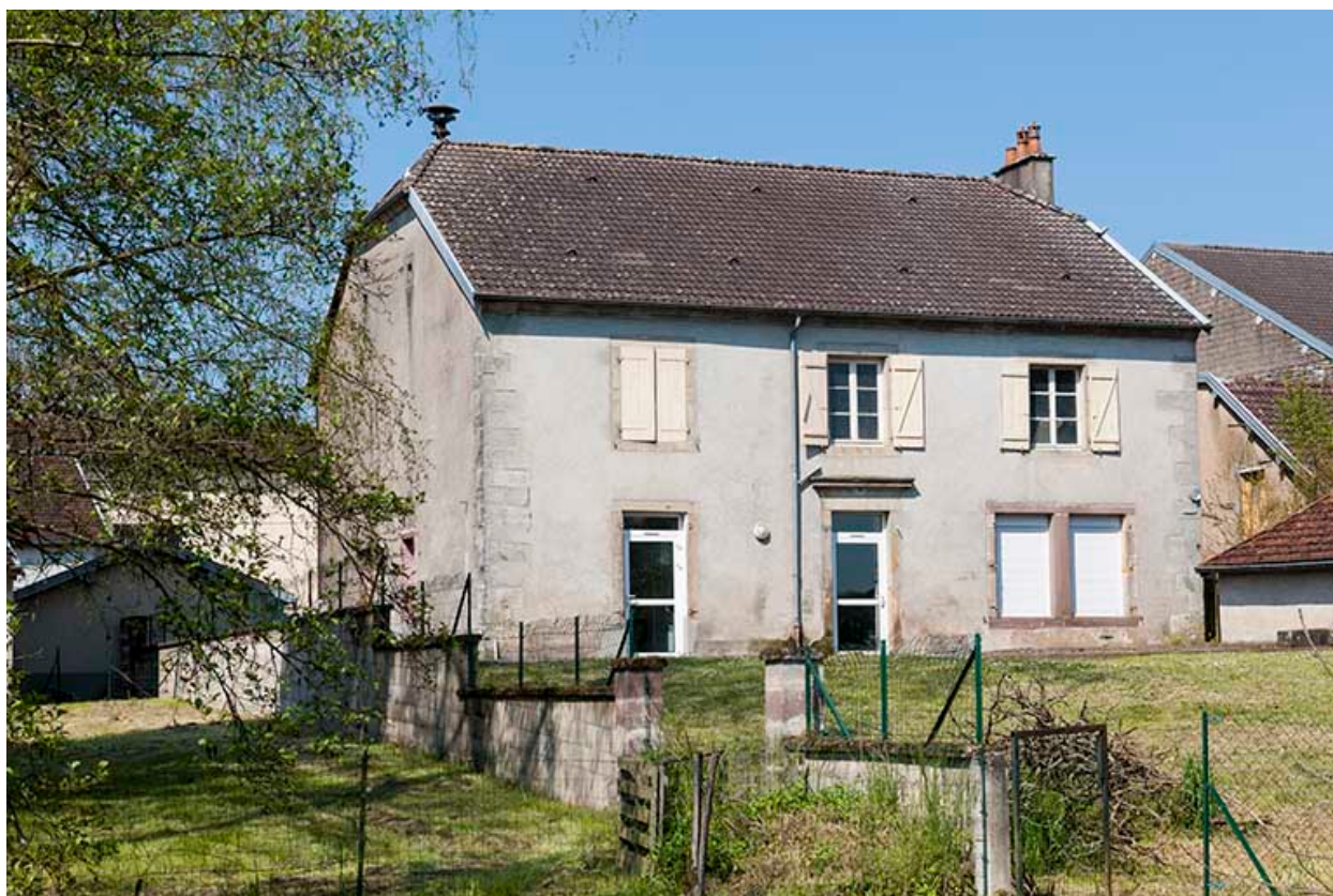
La façade postérieure.
