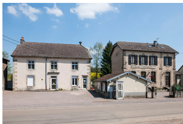
Vue d'ensemble. Phot. Jérôme Mongreville IVR43_20167000383NUC4A
