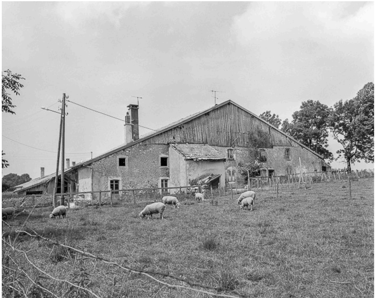
Pignon d'habitation et goutterot.
