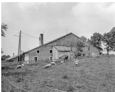
Pignon d'habitation et goutterot.
