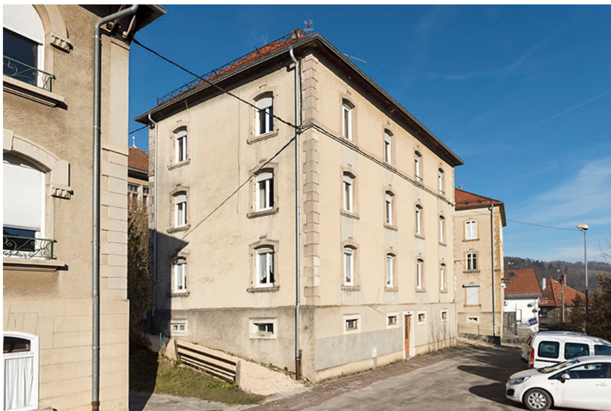
Façades antérieure et latérale gauche.
