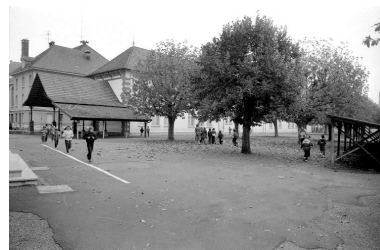
Vue de la cour. Phot. Bernard Lardière IVR43_19832500148Z
