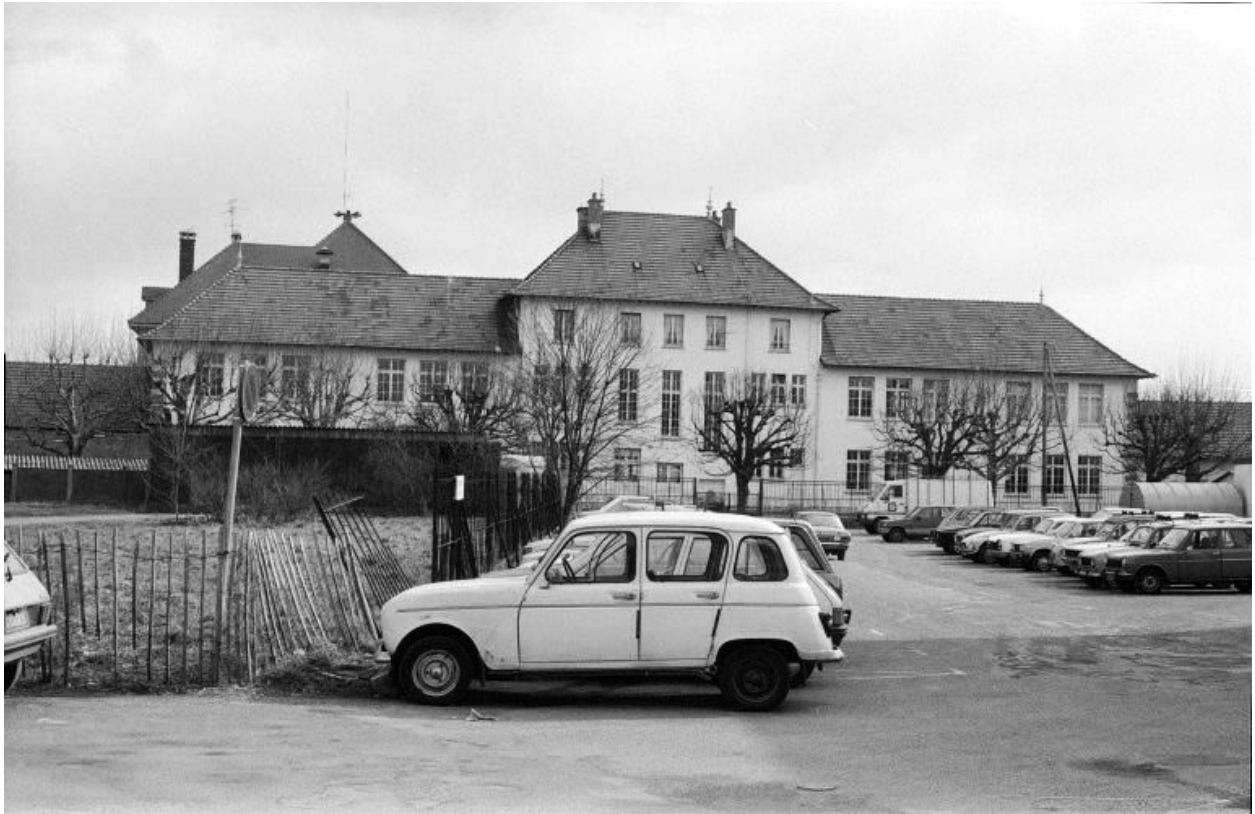
Façade postérieure sur cour.
