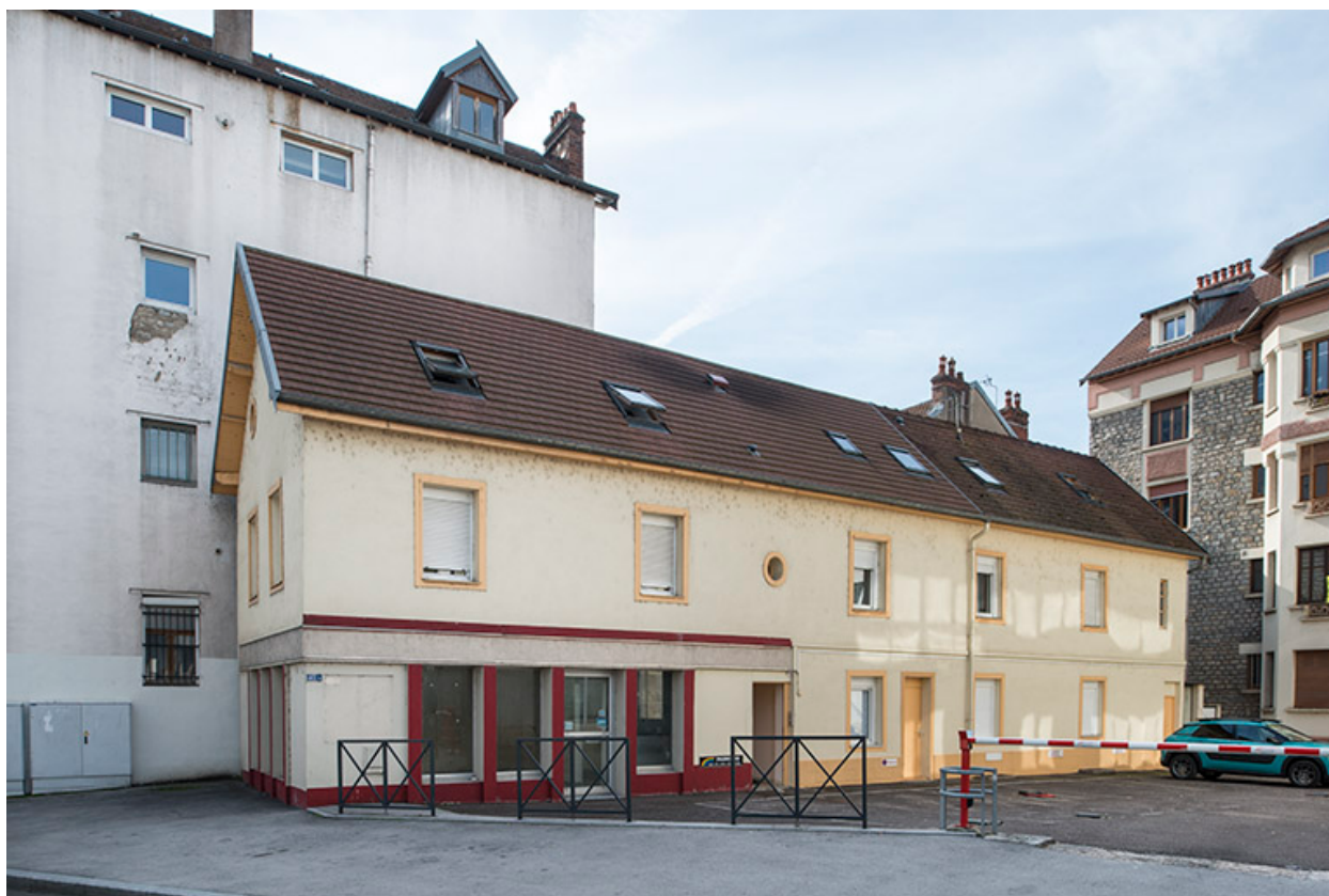
Façade nord de l'atelier.
