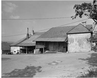
Gouttereau sur rue. Phot. Bernard Lardière IVR43_19782500333X
