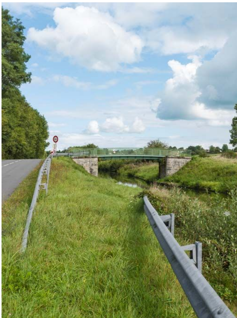
Vue d'ensemble du pont.
