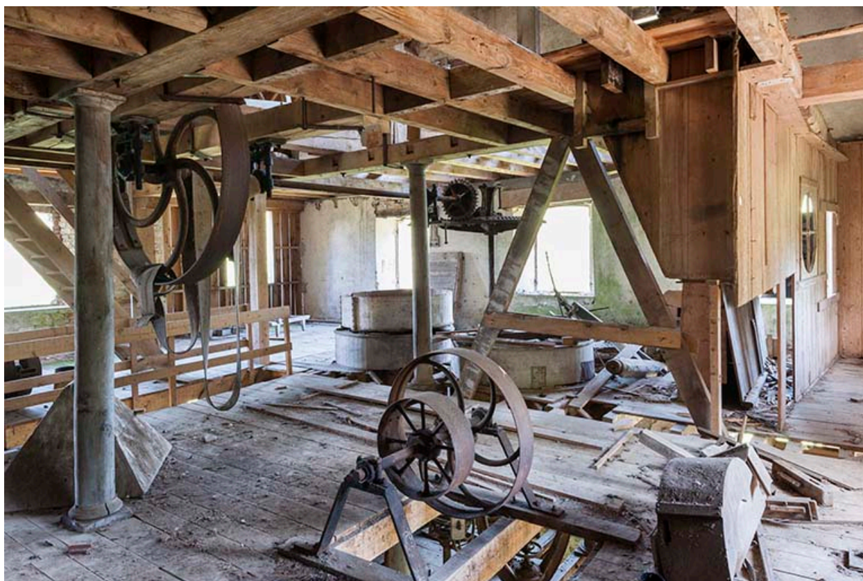
Premier étage. Vue d'ensemble depuis le sud-est.
