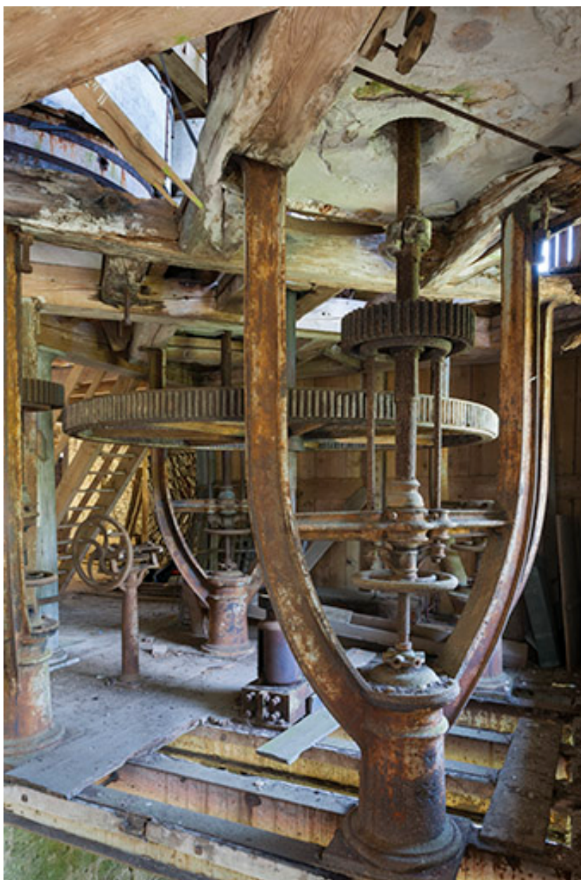
Rez-de-chaussée. Les colonnes "en lyre" du beffroi.
