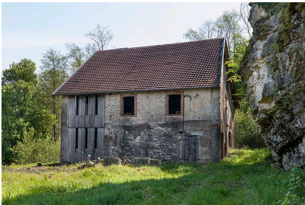
Vue d'ensemble depuis l'ouest.
