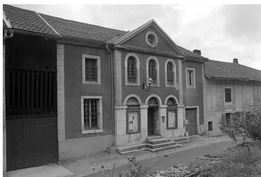
Façade antérieure. Phot. Jérôme Mongreville IVR43_19963901598X
