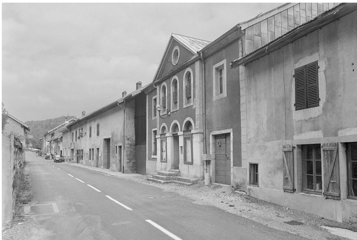
Vue depuis la rue principale.
