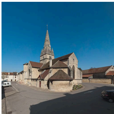
Vue d'ensemble côté chevet. Phot. Pierre-Marie Barbe-Richaud IVR26_20122101011NUC4AQ
