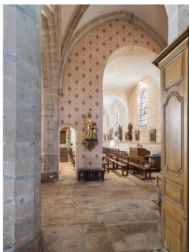
Arcades du mur ouest de la chapelle nord. Phot. Pierre-Marie Barbe-Richaud IVR26_20162100474NUC2A
