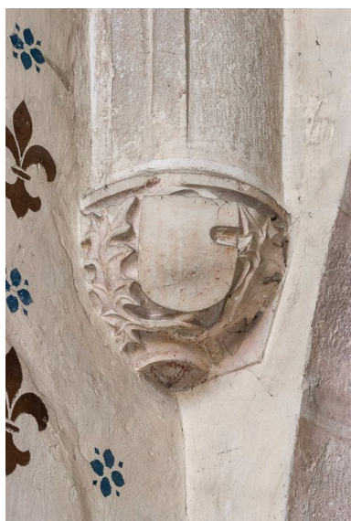
Chapelle sud, détail d'un culot. Phot. Pierre-Marie Barbe-Richaud IVR26_20162100498NUC2A
