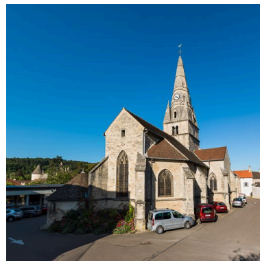
Vue d'ensemble, côté chevet. Phot. Pierre-Marie Barbe-Richaud IVR26_20152100551NUC4AQ
