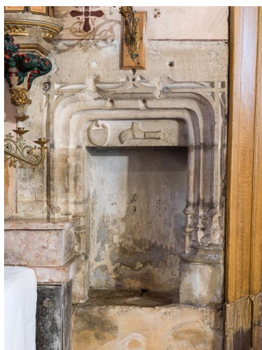
Lavabo de la chapelle nord. Phot. Pierre-Marie Barbe-Richaud
