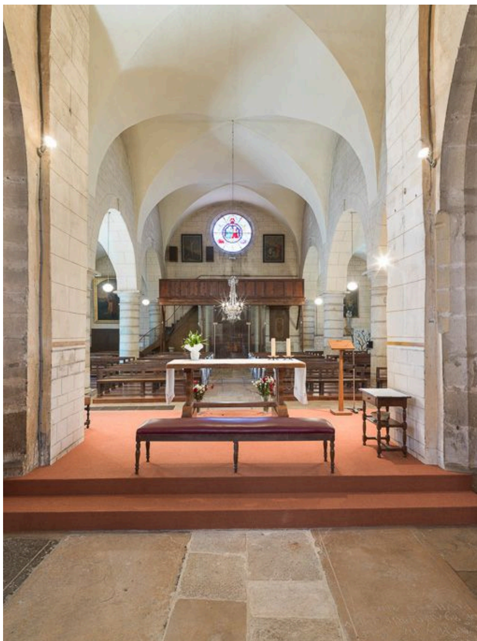
Vue d'ensemble depuis la travée sous clocher.
