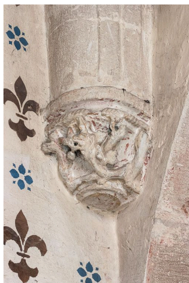
Chapelle sud, détail d'un culot. Phot. Pierre-Marie Barbe-Richaud IVR26_20162100499NUC2A
