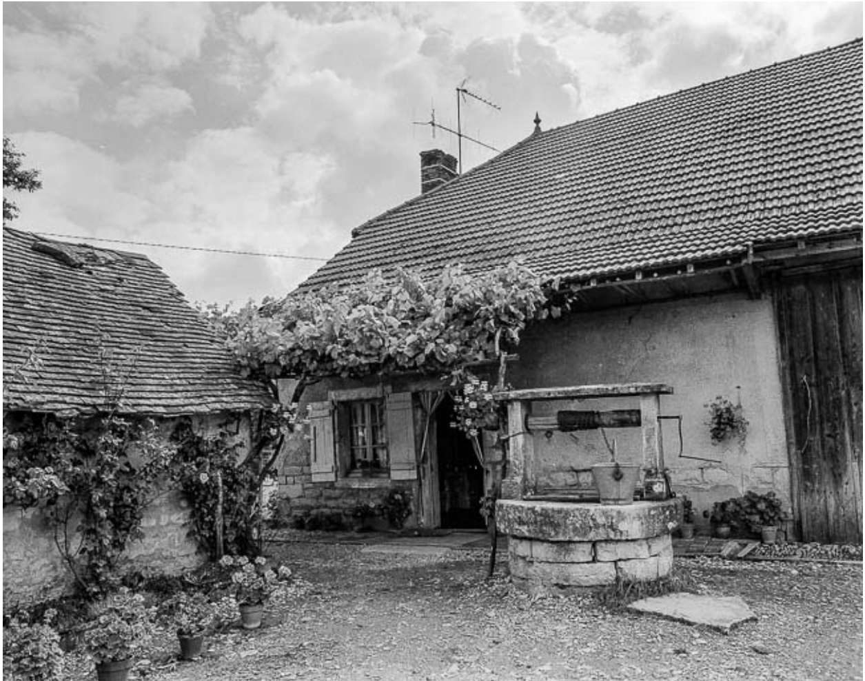
Façade antérieure de l'habitation.
