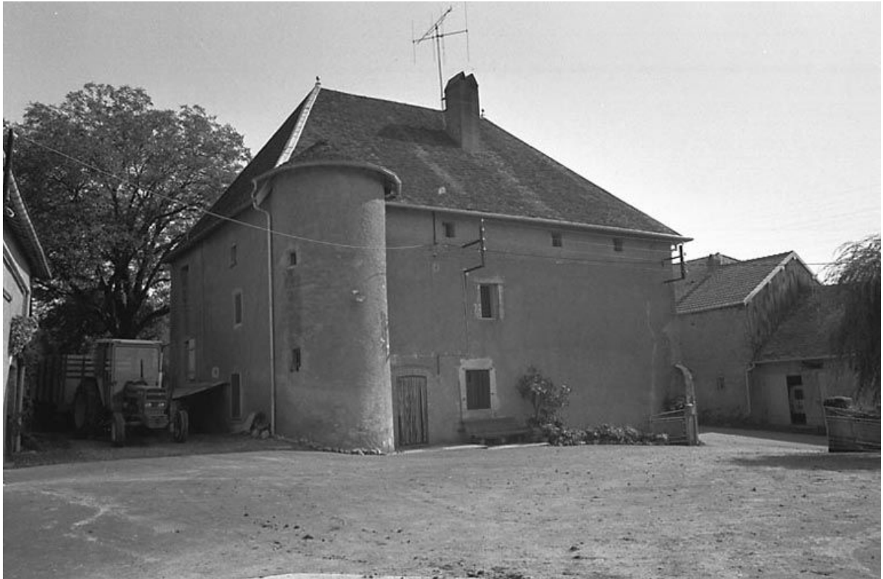
Vue de l'habitation.
