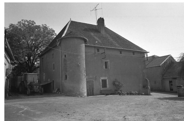
Vue de l'habitation.
