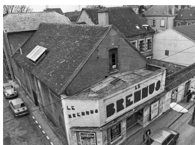
Cinéma le Brennus [vue plongeante]. S.d. [1977]. Autr. auteur inconnu IVR26_20238900276NUC4A
