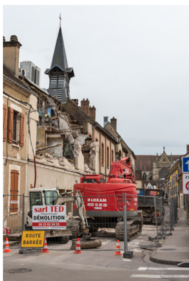
Cinéma Vox (14 rue Victor Guichard) en cours de démolition (22 mars 2023). Phot. Pierre-Marie Barbe-Richaud IVR26_20238900266NUC4A
