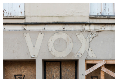
Traces de l'enseigne du Vox (février 2023). Phot. Pierre-Marie Barbe-Richaud IVR26_20238900224NUC4A
