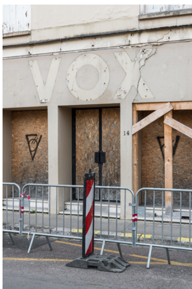
Entrée du Vox, de trois quarts droite (février 2023). Phot. Pierre-Marie Barbe-Richaud IVR26_20238900225NUC4A
